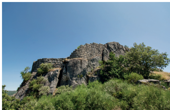
Articulação da muralha com os afloramentos rochosos
