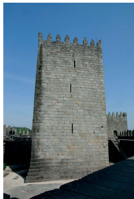
Vista geral da Torre de Menagem
