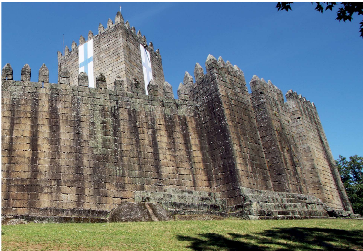
Vista de nascente vendo-se, em baixo, vestígios da fase condal (século XI)
