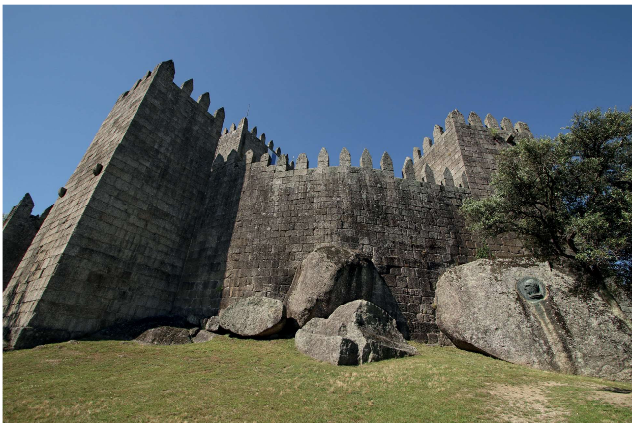
Vista da muralha oeste, entre a torre do sino de correr e a torre sul
