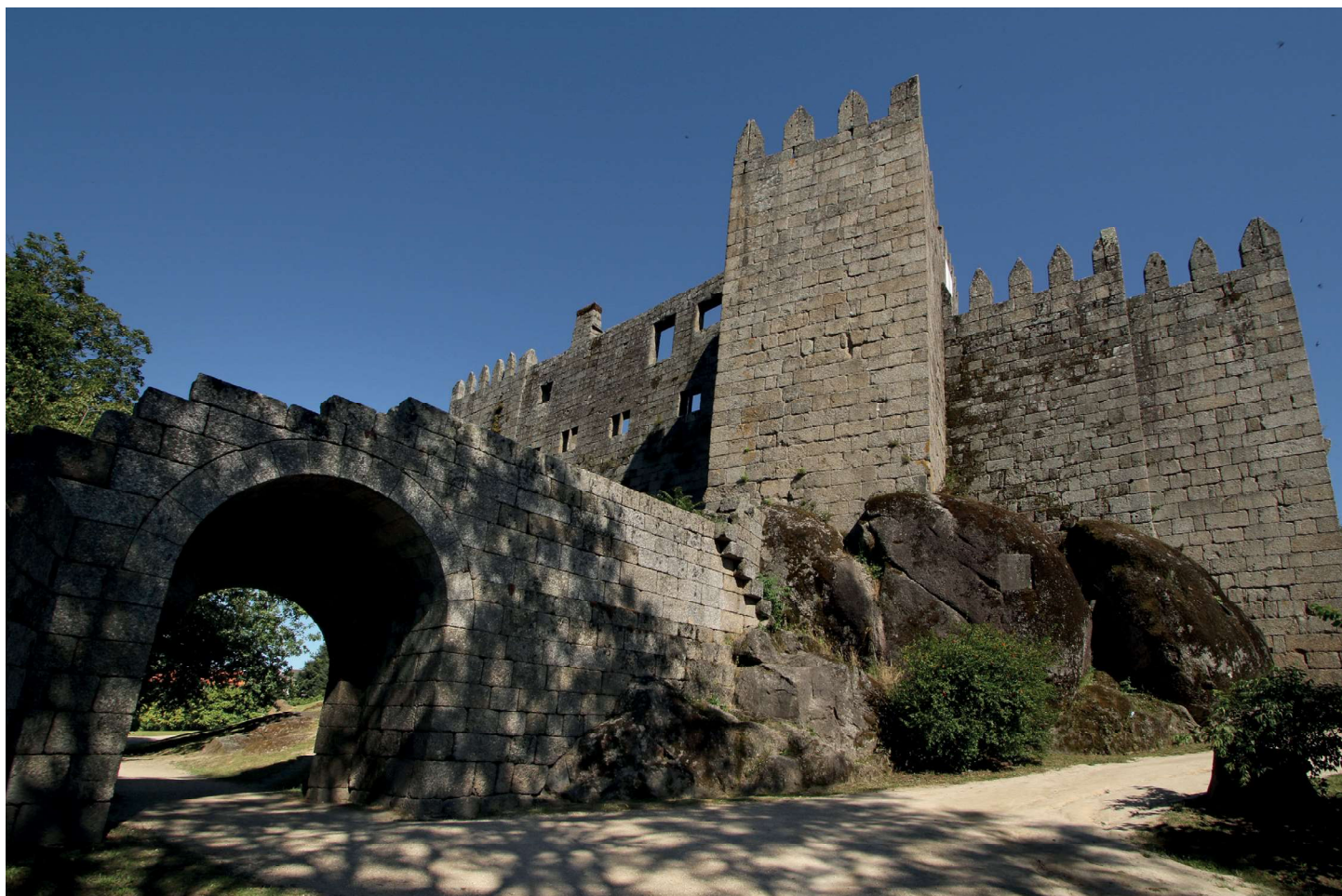
Vista do torreão noroeste
