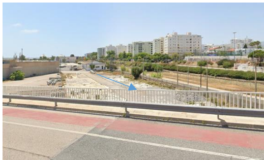
Figura 41. Viaduto da Estrada dos Moinhos a Palmeira
