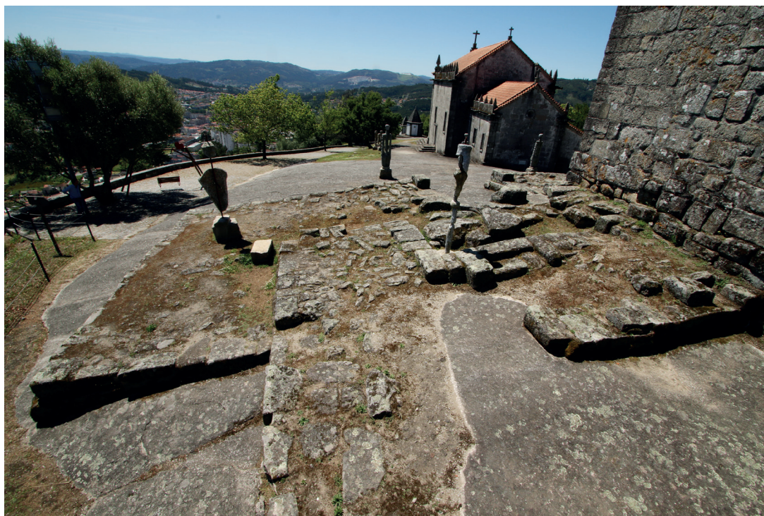
Vestígios da sapata dentada pré-românica e do alicerce do primeiro torreão
