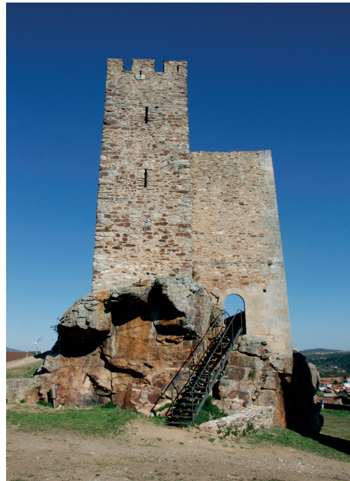
Face oeste da Torre de Menagem
