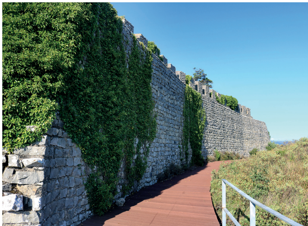
Interior do castelo. Muralla norte
