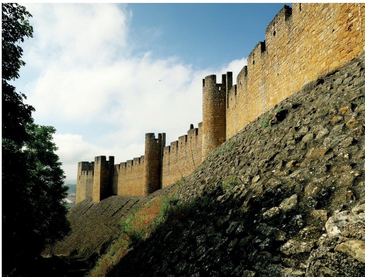
Castelo de Tomar. Alambor na base da muralha
