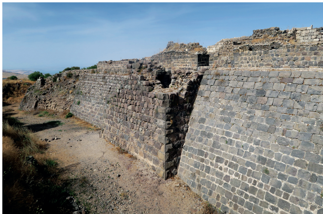
Alambor no castelo cruzado de Belvoir ou Kokhav ha-Yarden (Israel). Esta estrutura, comum nos castelos cristãos da Terra Santa, foi o modelo aplicado por D. Gualdim Pais em vários castelos templários em Portugal (Foto JNG)
