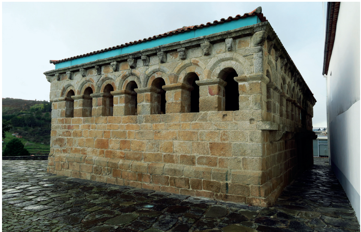
Paço da Cisterna visto de este
