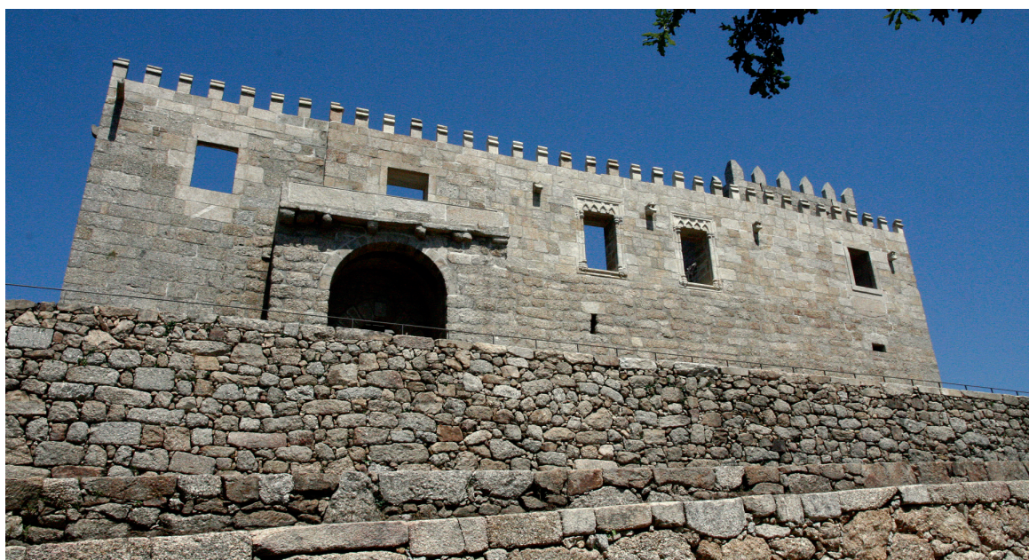
Alçado sudoeste. Vista geral do paço manuelino
