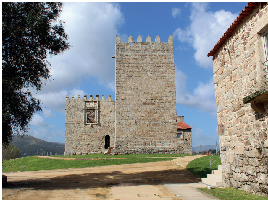
Vista geral (paço e torre). Alçado sudeste
