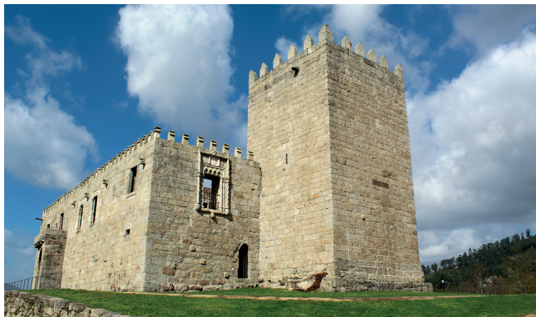
Vista geral (paço e torre). Alçados sudeste e sudoeste
