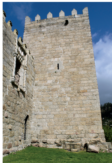
Torre medieval. Alçado sudoeste
