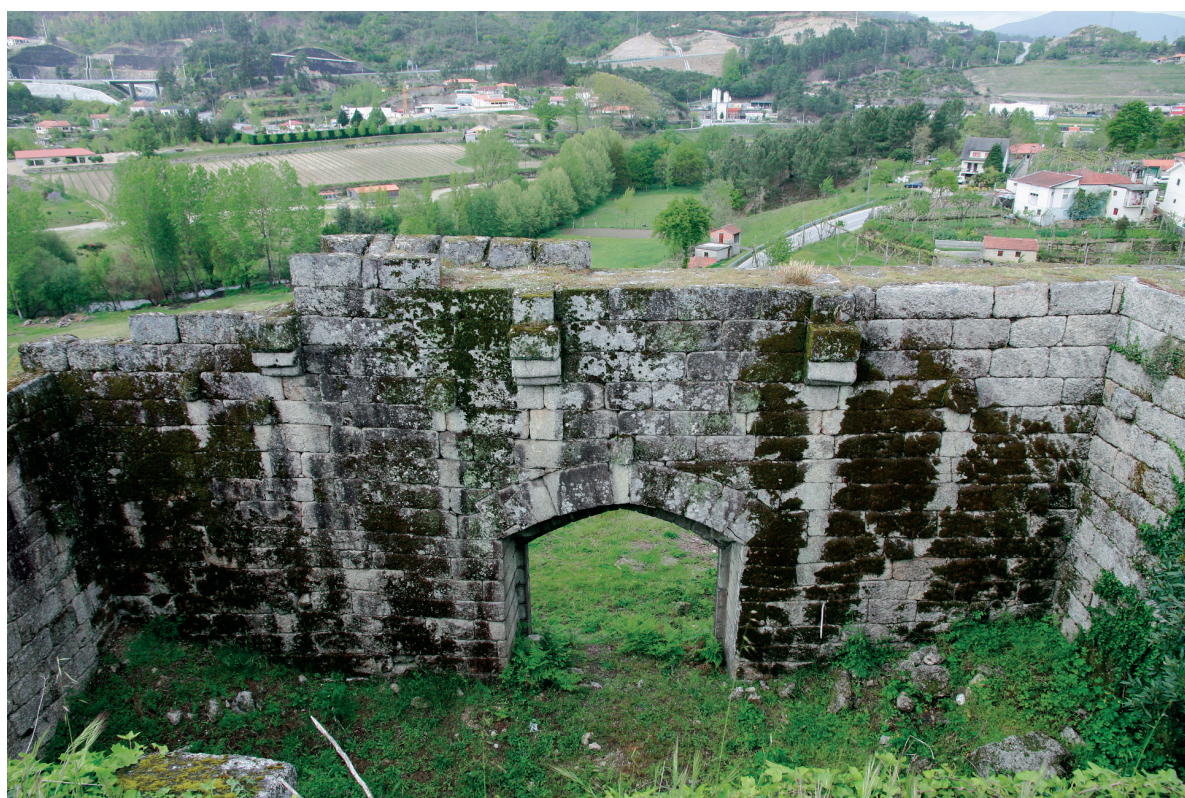
Porta de entrada (vista interior)
