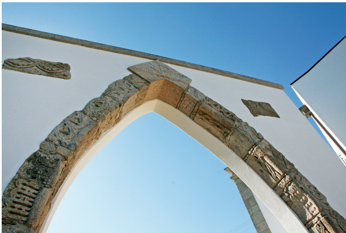
Exterior. Arco do adro. Alçado este. Pormenor
