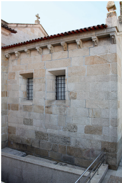
Alçado sul. Perspetiva geral da cabeceira
