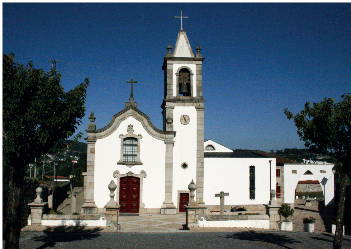
Perspetiva geral da igreja. Alçado oeste
