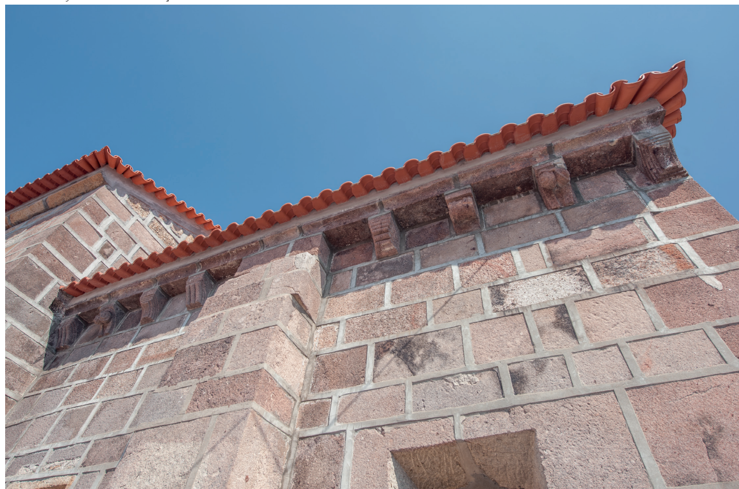
Abside. Contraforte e cachorrada no alçado sul
