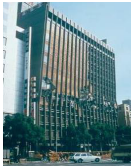
b) Efeito “soft-storey” nos pisos superiores (Bachmann, 2003)
