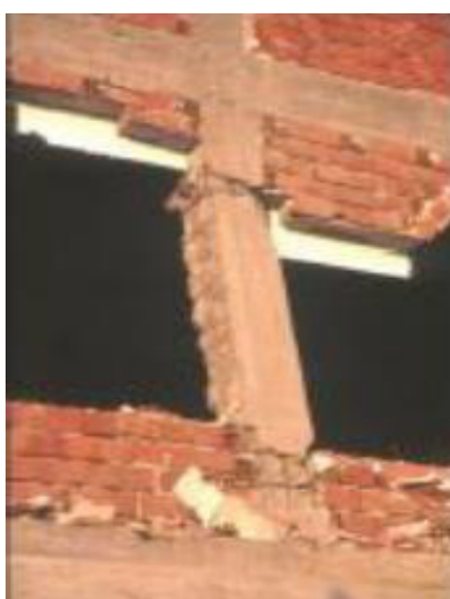
a) Exemplo do efeito de “pilar curto” (Varum, 2003)
