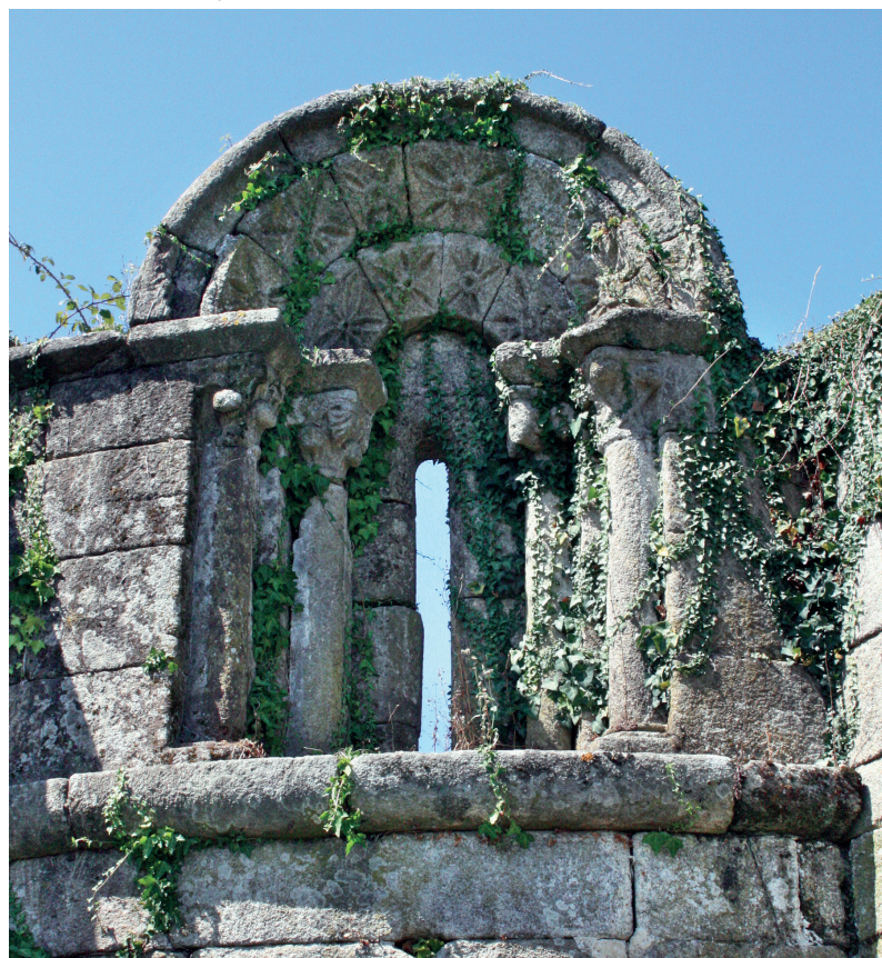
Ruína da cabeceira. Alçado este. Fresta
