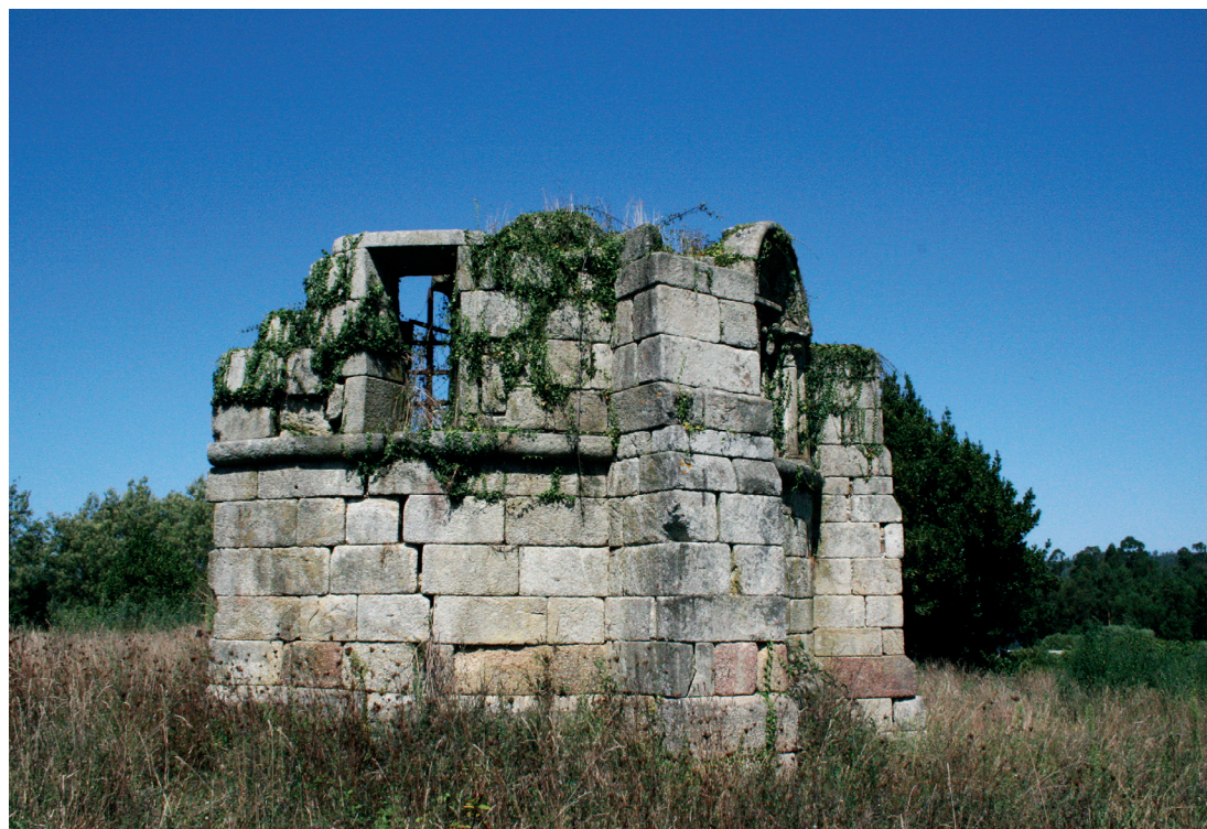
Ruína da cabeceira. Alçado sul
