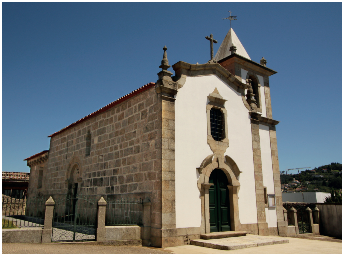
Perspetiva geral da igreja. Alçados oeste e norte
