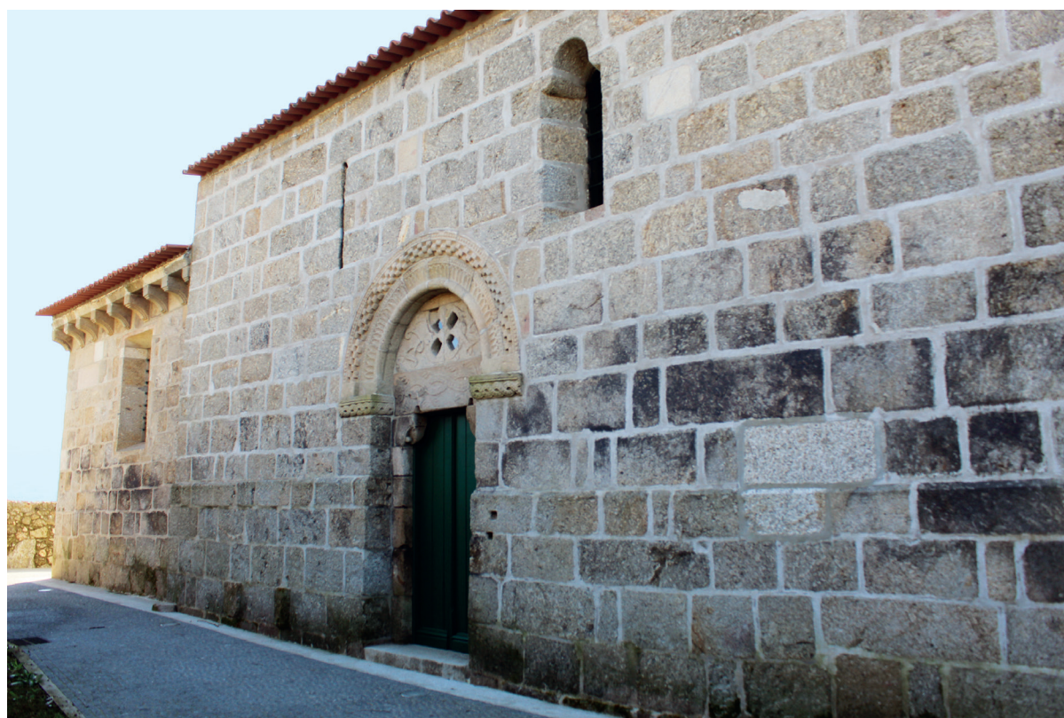
Perspetiva geral da igreja. Alçado norte
