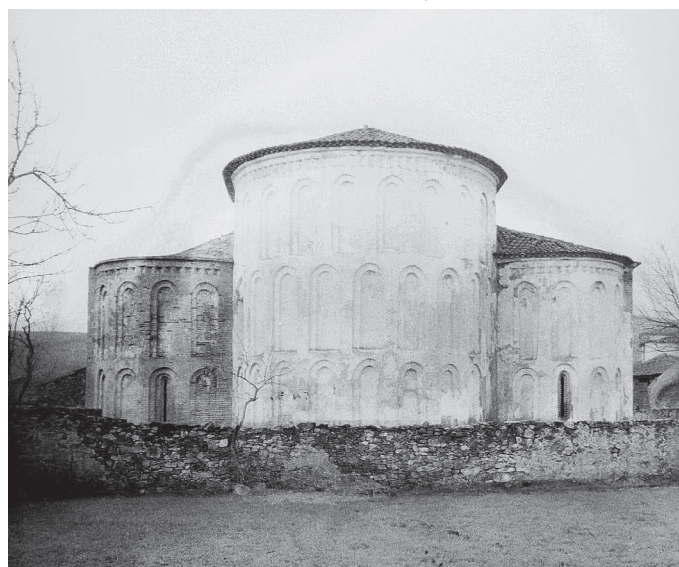
Vista geral da cabeceira da igreja após a reconstituição feita pela DGEMN
