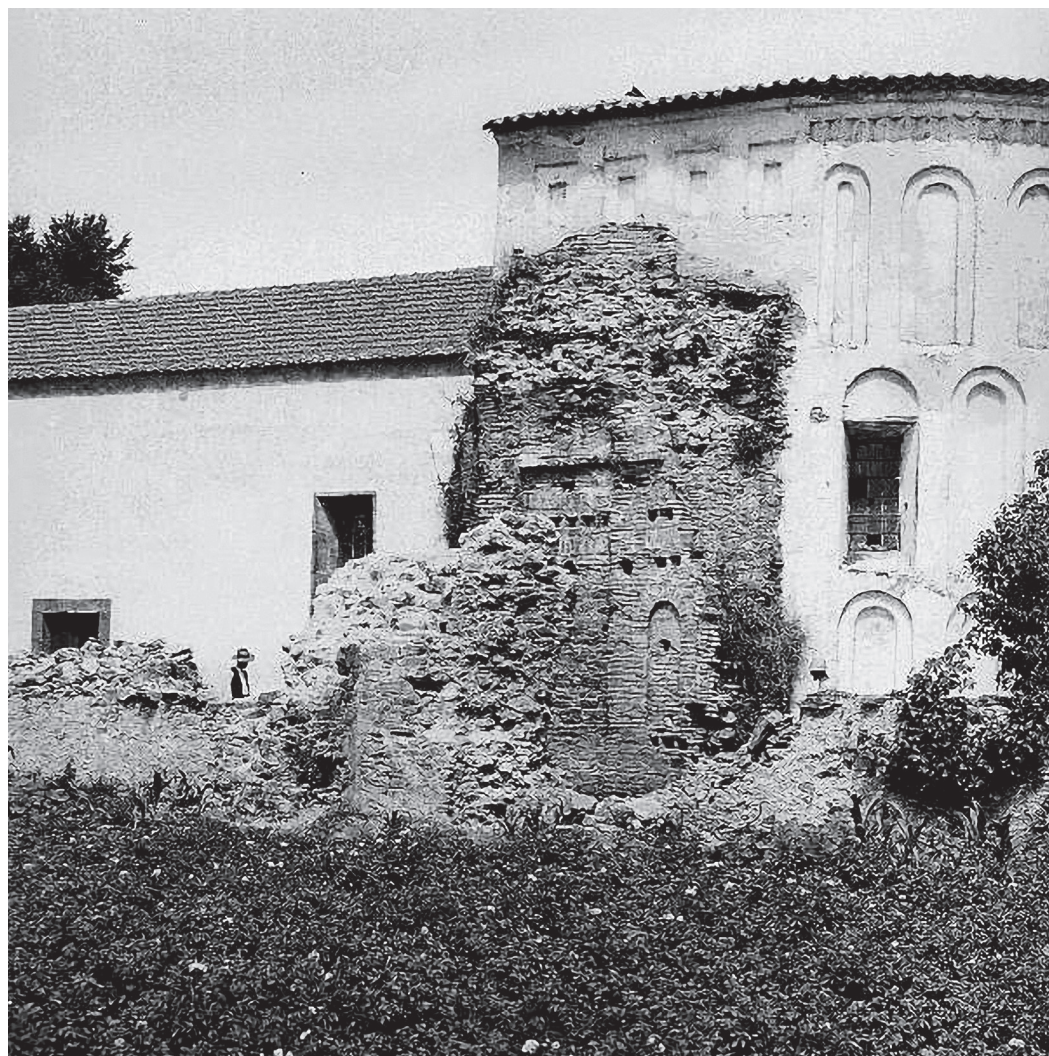
Alçado sul, vestígios do absidiolo da Epístola (DGEMN)
