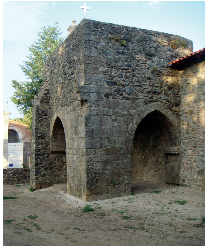
Torre no adro da igreja
