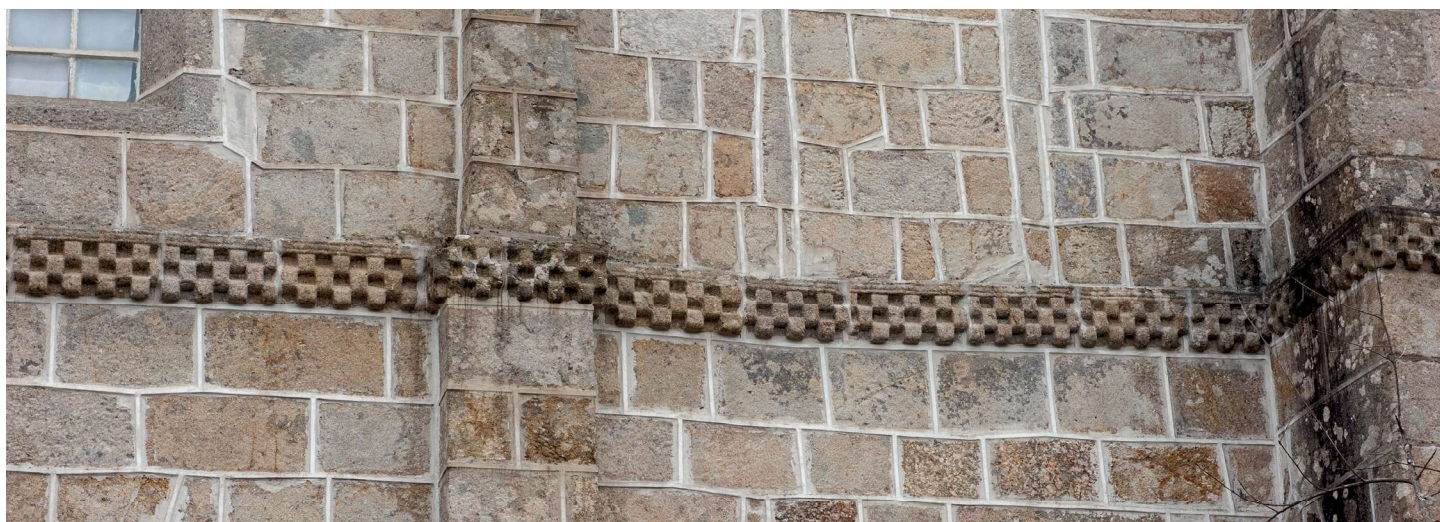
Exterior. Alçado norte. Trechos de paramento
