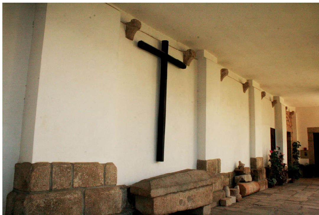
Claustro. Ala com pedras avulsas. Ao fundo, porta de acesso à igreja com cicatriz de portal
