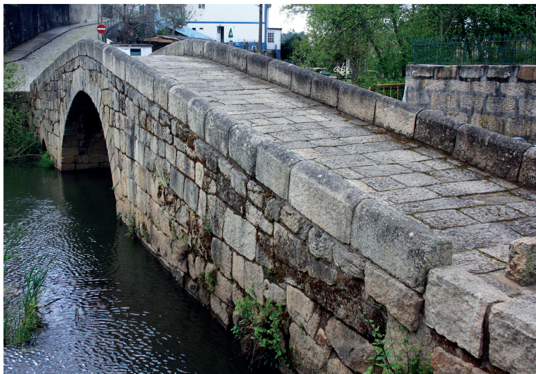
Vista a jusante. Perfil da ponte
