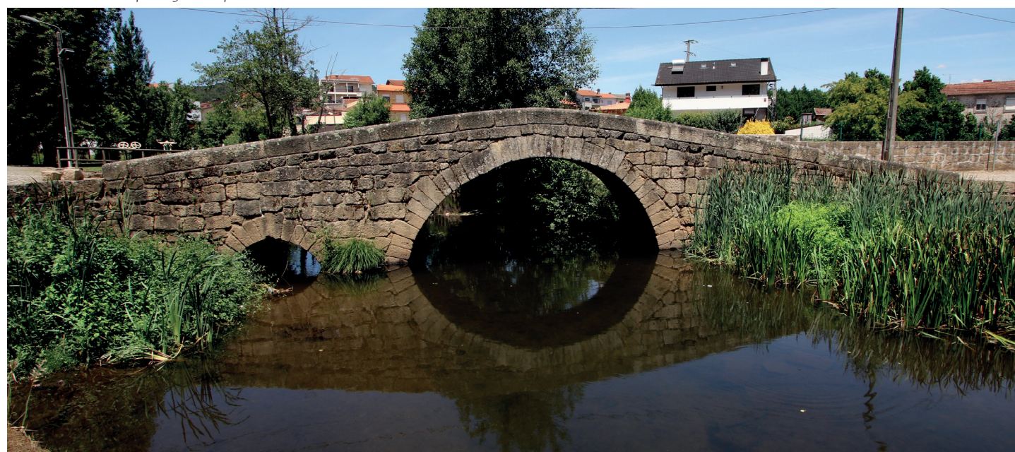
Vista a montante. Perspetiva geral da ponte
