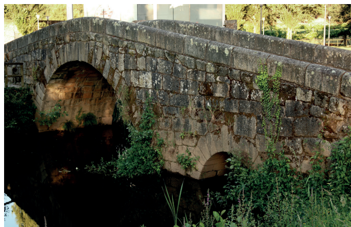
Vista a jusante. Pormenor dos vãos
