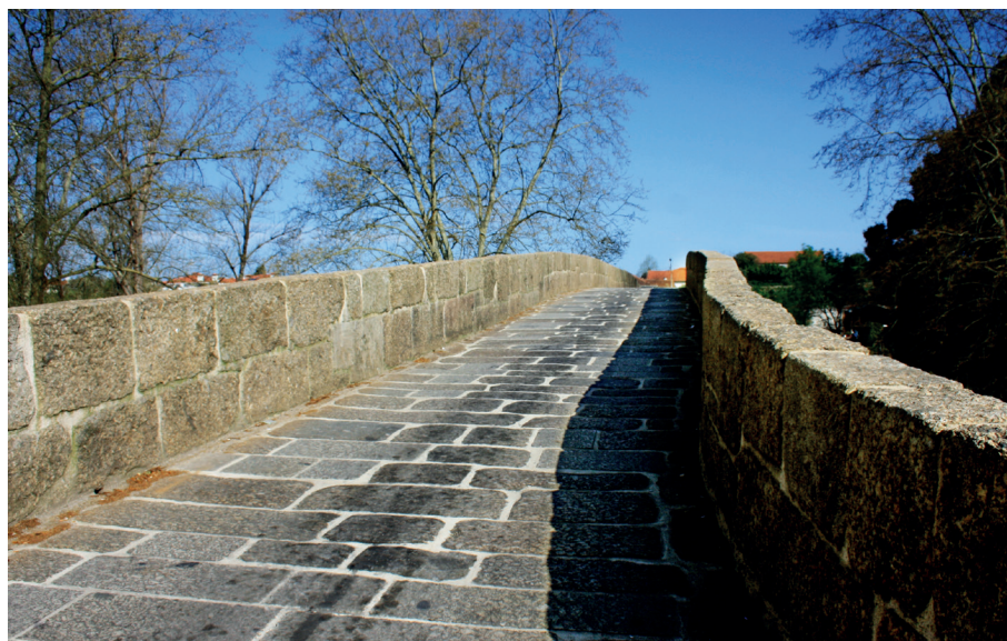
Perspetiva sobre o tabuleiro, pavimento e guardas
