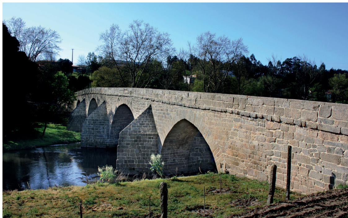
Vista a montante. Perspectiva geral da ponte. Margem direita
