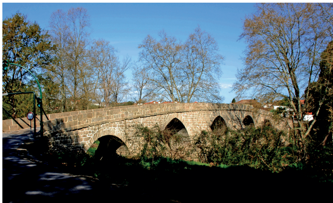
Vista a montante. Perspectiva geral da ponte. Margem esquerda
