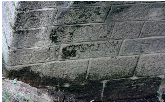
Silhares siglados no intradorso do primeiro arco da margem direita
