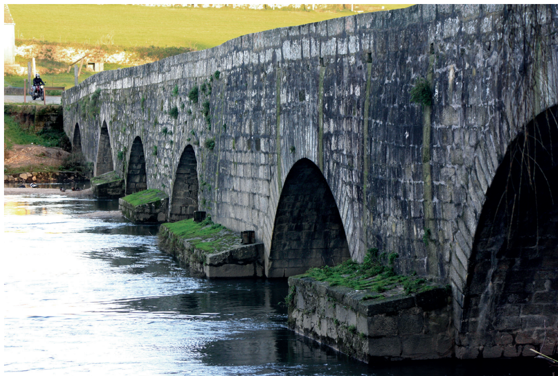
Perspetiva da ponte a jusante
