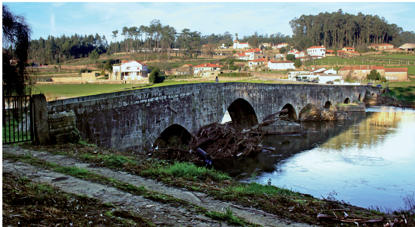
Perspetiva da ponte a montante
