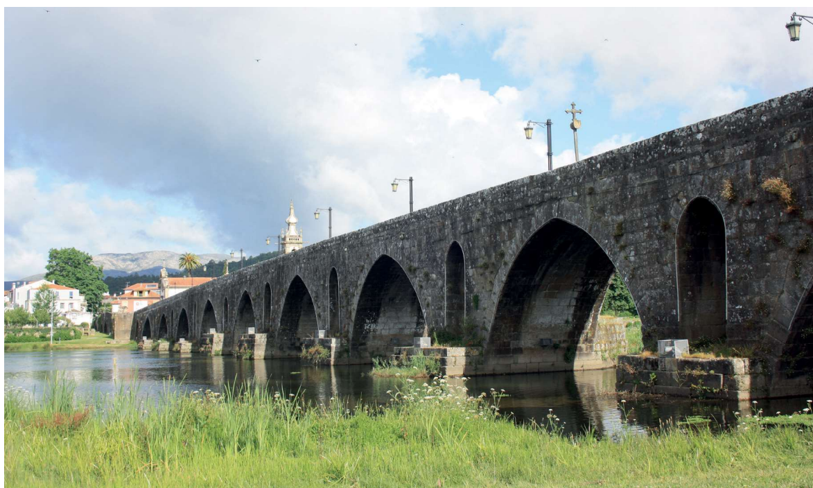
Perspetiva da ponte a jusante
