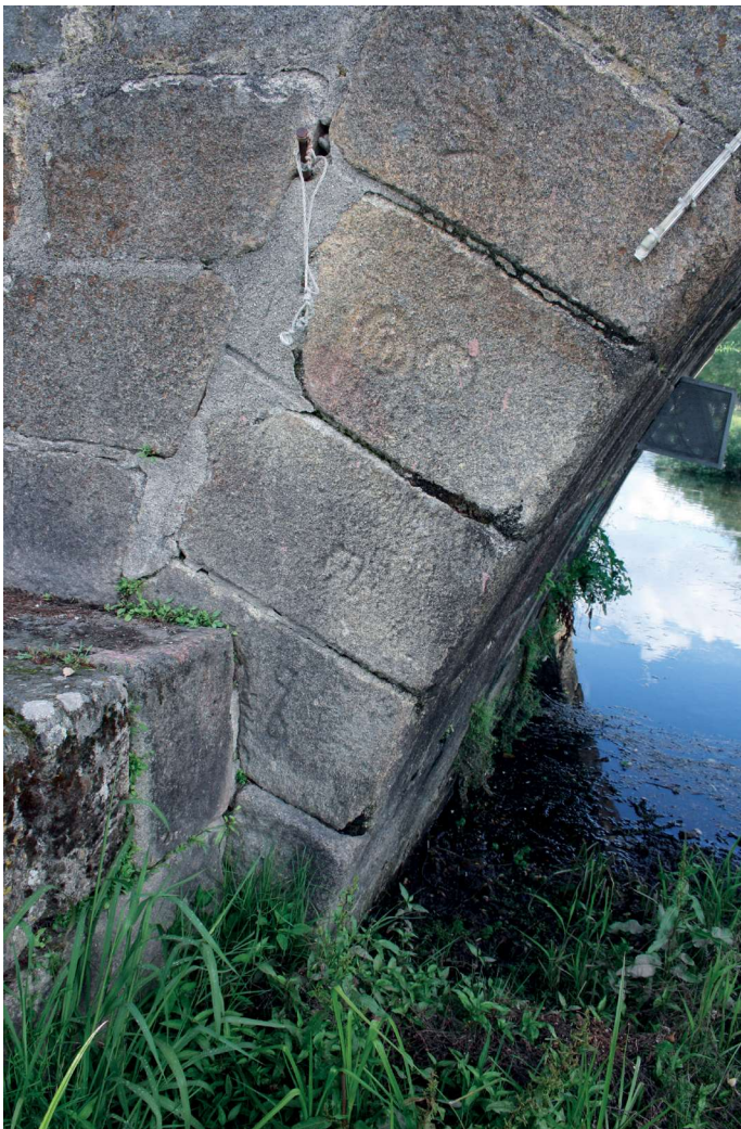
Silhares siglados nas aduelas de arco na margem esquerda
