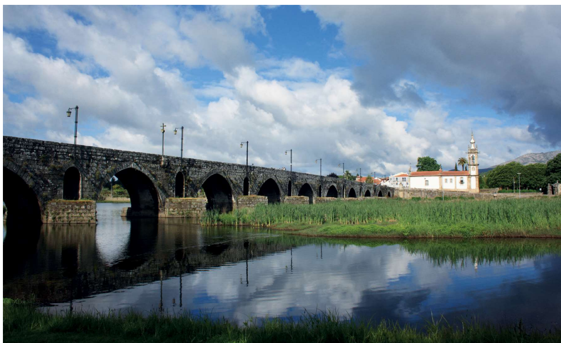
Perspetiva da ponte a montante
