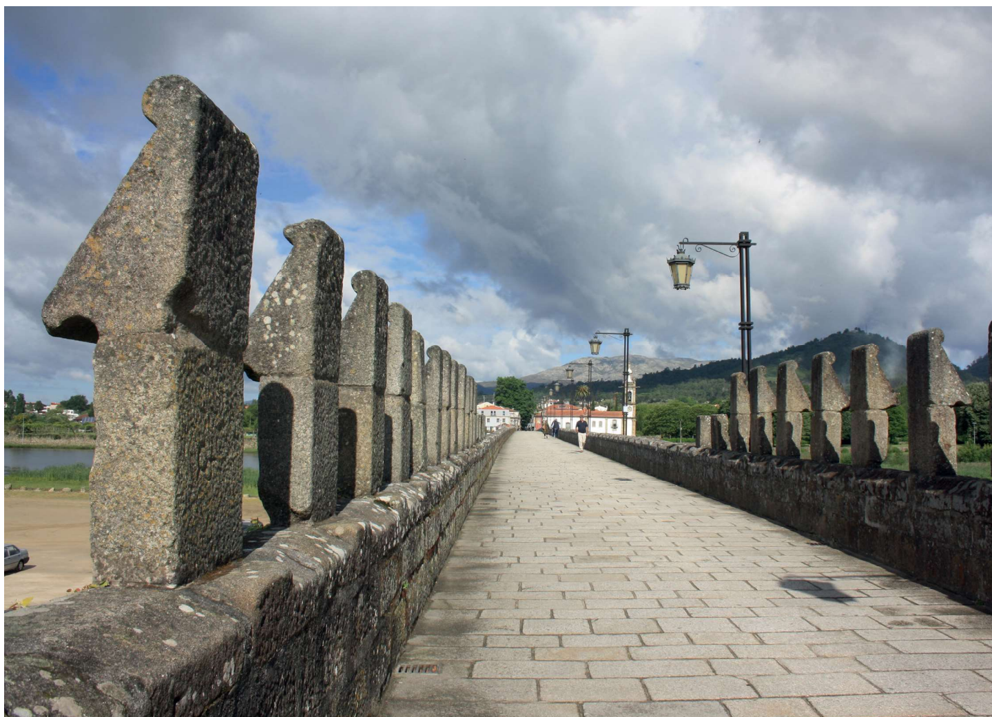
Guardas e merlões junto ao arranque da ponte na margem esquerda
