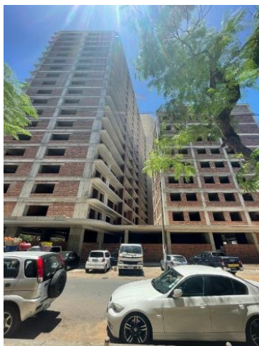
Figura 3.3- Vista da Av. Armando Tivane
