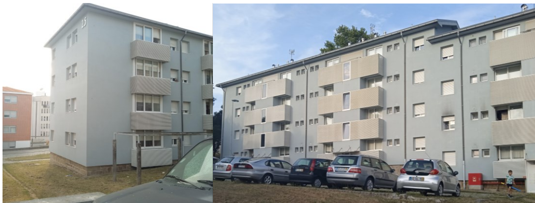
Fig. 31 - Bloco 25 do Bairro do Cerco do Porto - ETICS
