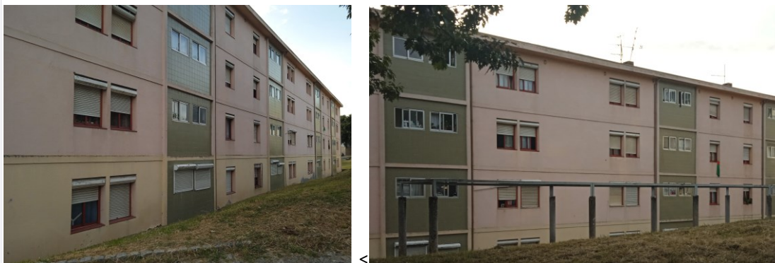
Fig. 19 - Bloco edifício "reabilitado", intervenção de melhorias por pintura
