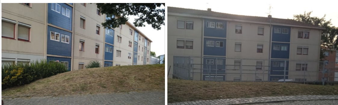
Fig. 20 - Bloco edifício "reabilitado", intervenção de melhorias por pintura
