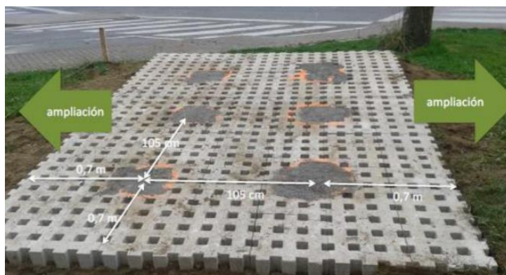
Figura 4.19: Medidas de base para a instalação de 2 módulos de compostagem. Fonte: Fonseca, 2022: p. 65.
