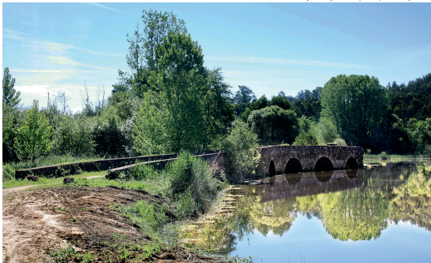
Ponte do Cabeço de Vouga. Vista a jusante (desde a margem norte)
