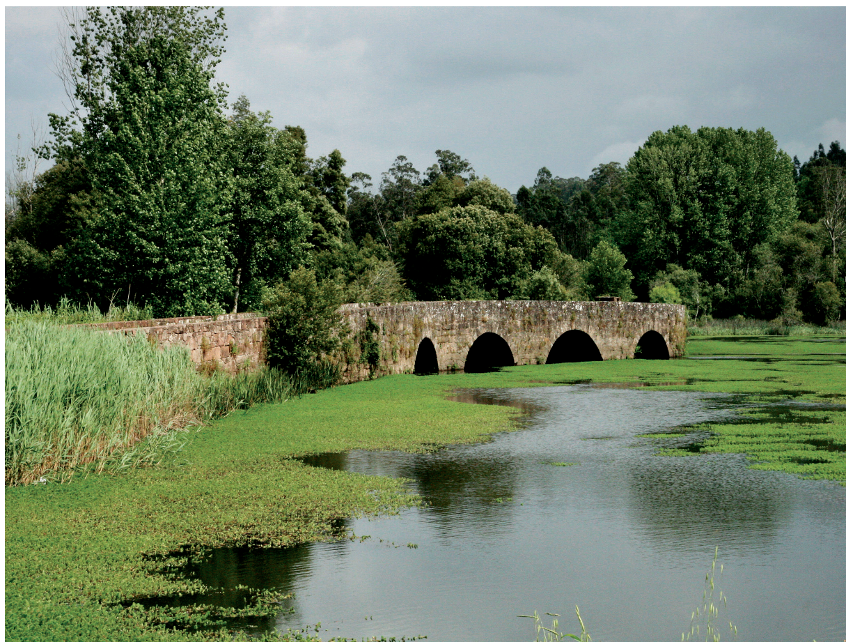
Ponte do Cabeço de Vouga. Vista a jusante
