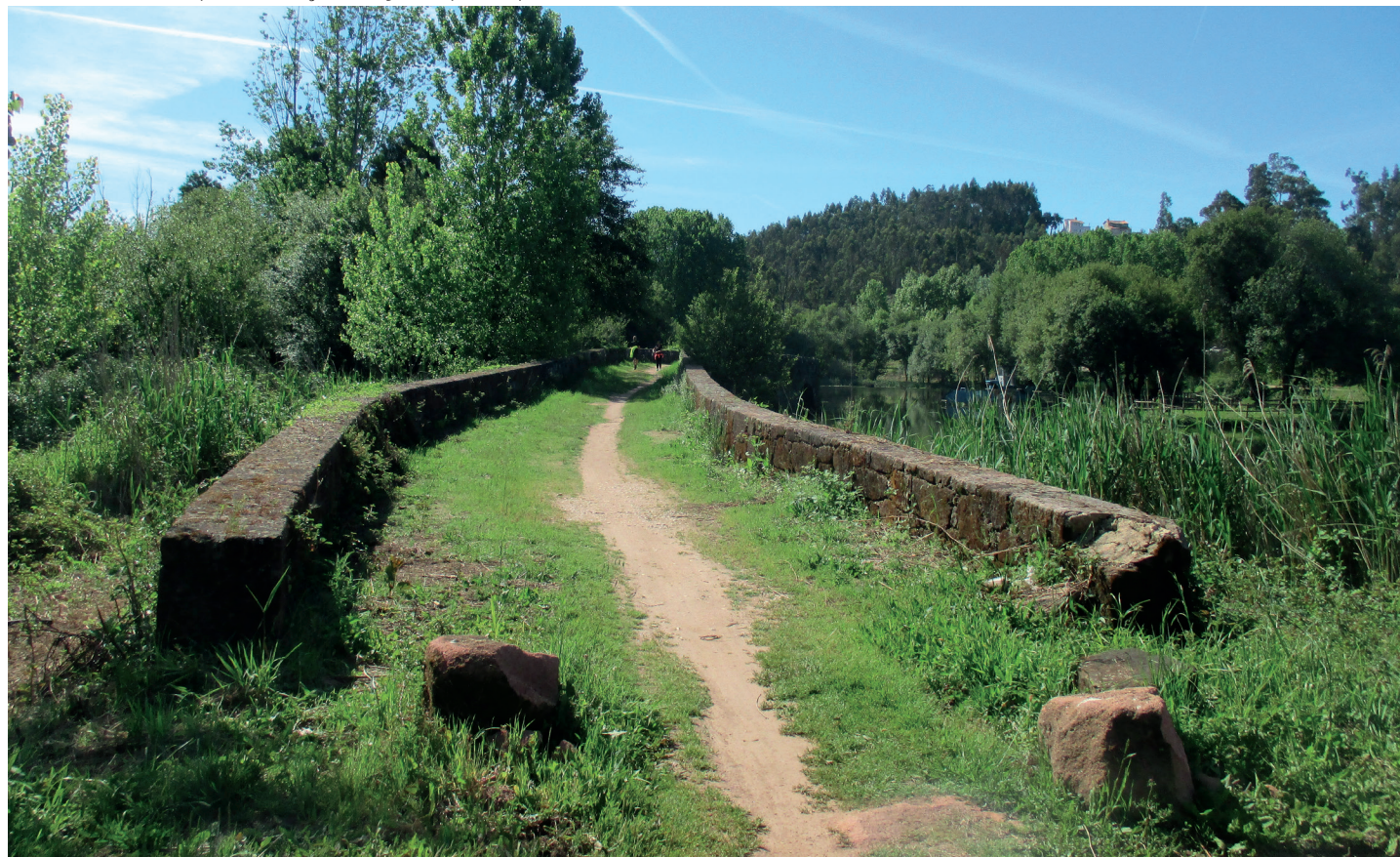
Entrada no tabuleiro da ponte de Cabeço de Vouga. Perspetiva a partir do norte
