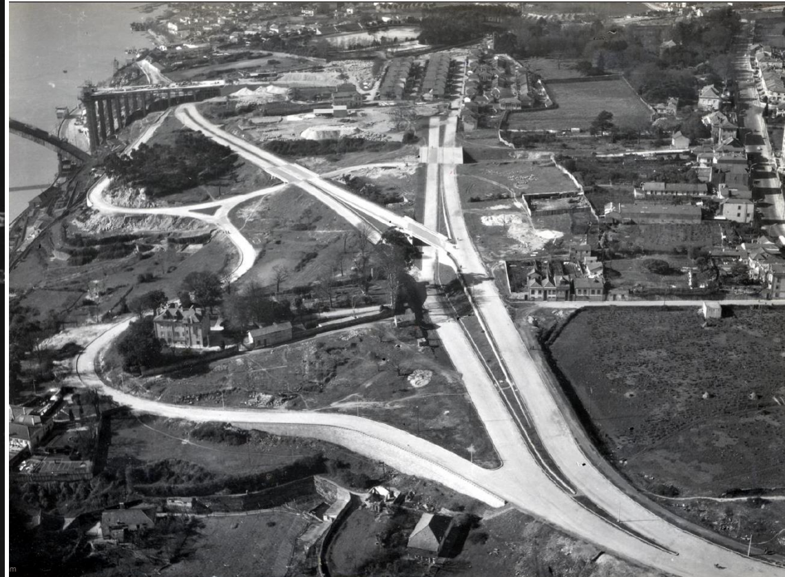
Vista aérea da construção da ponte da Arrábida (1959-1962). Fonte: Arquivo Municipal do Porto, consulta pública em rb.gy/h2i7cm .
