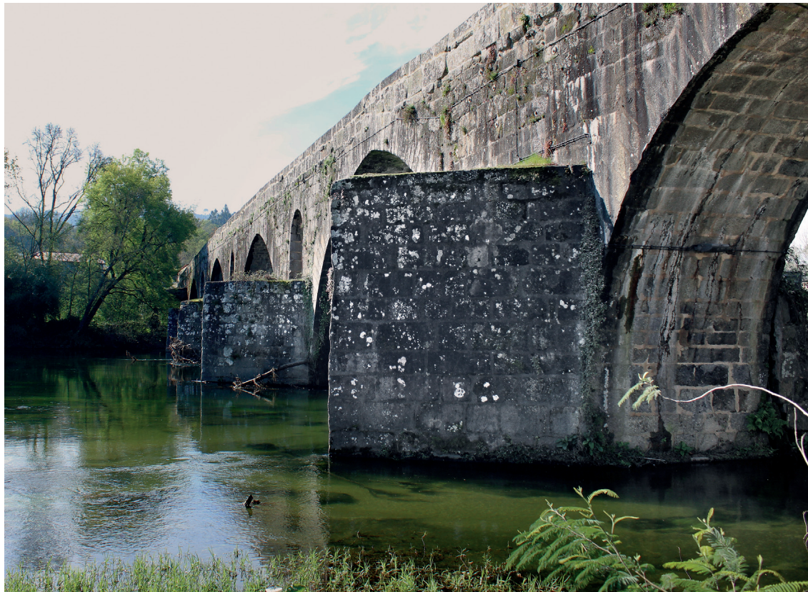
Pespetiva da ponte amontante. Talhamares
