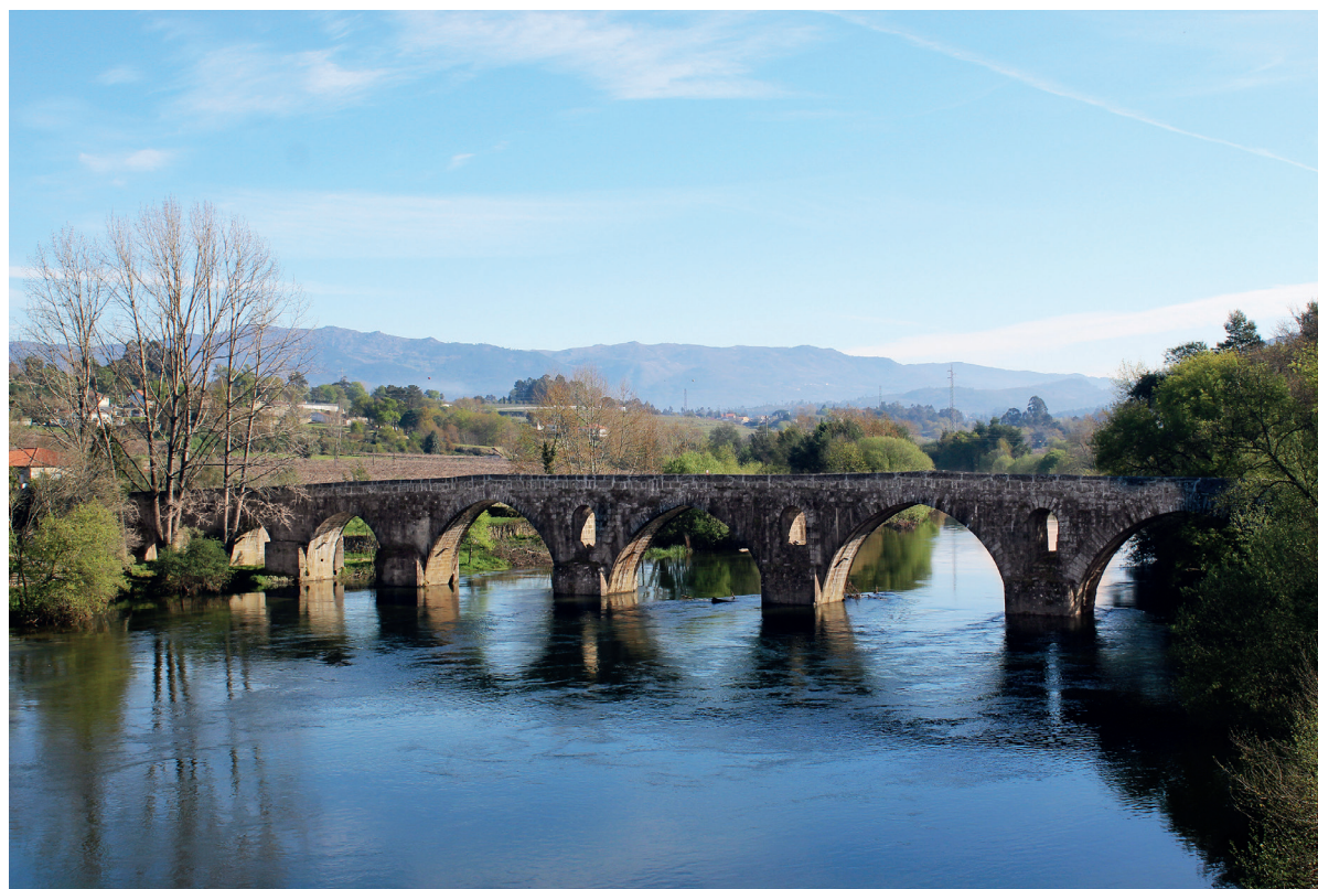
Perspetiva geral da ponte a jusante
