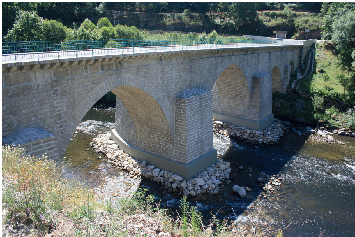
Vista a jusante. Perfil da ponte
