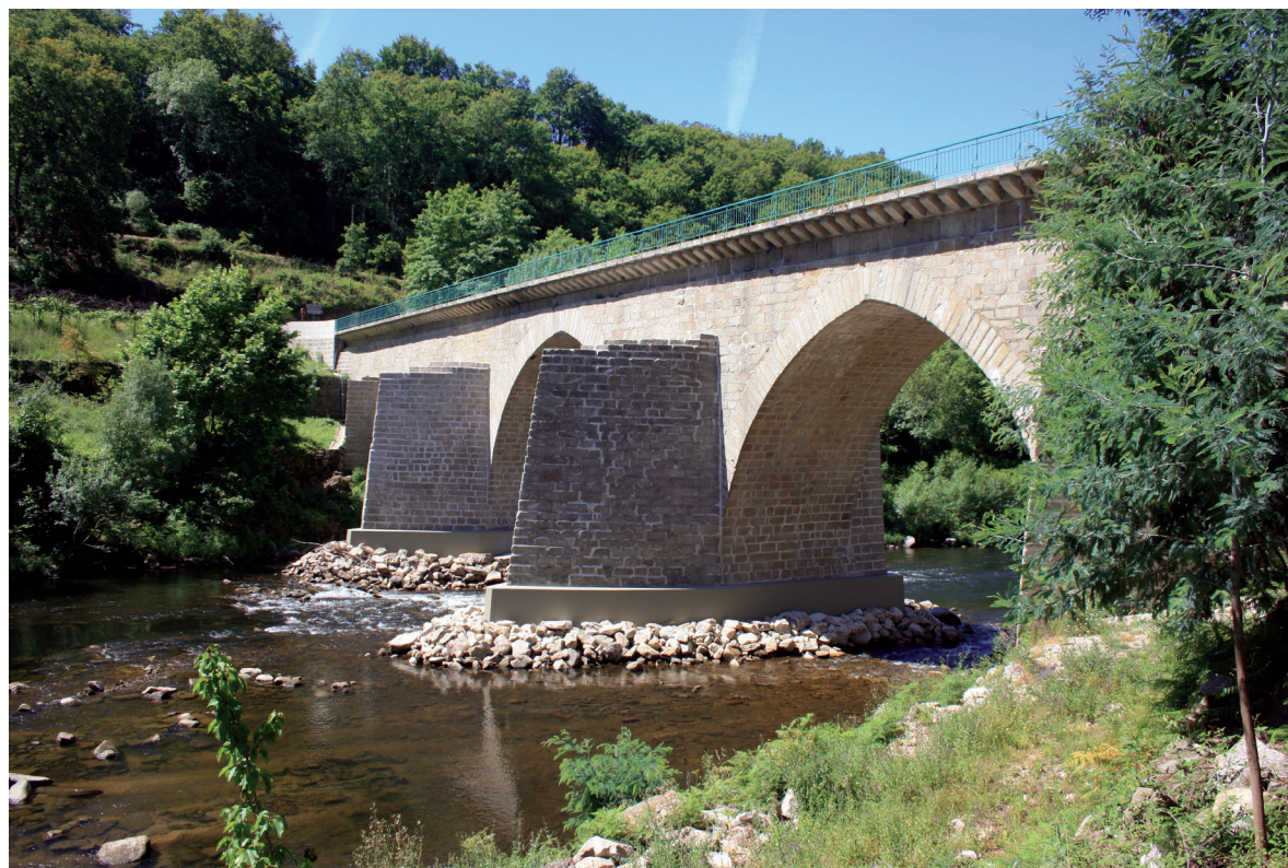
Vista a montante
