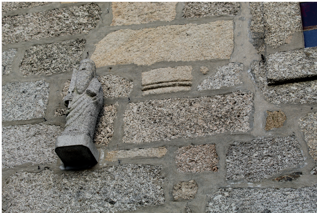
Alçado oeste. Estátua de São Bartolomeu e aduela românica
