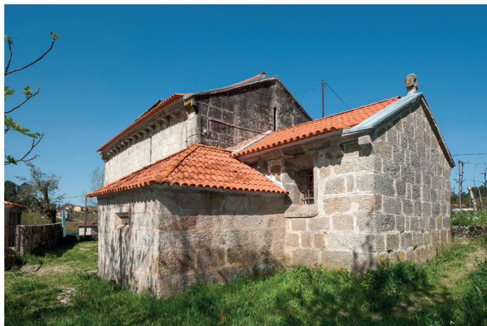
Exterior. Alçado este
