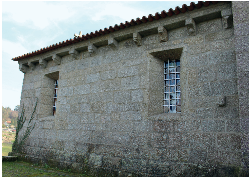
Exterior. Capela-mor. Lado norte
