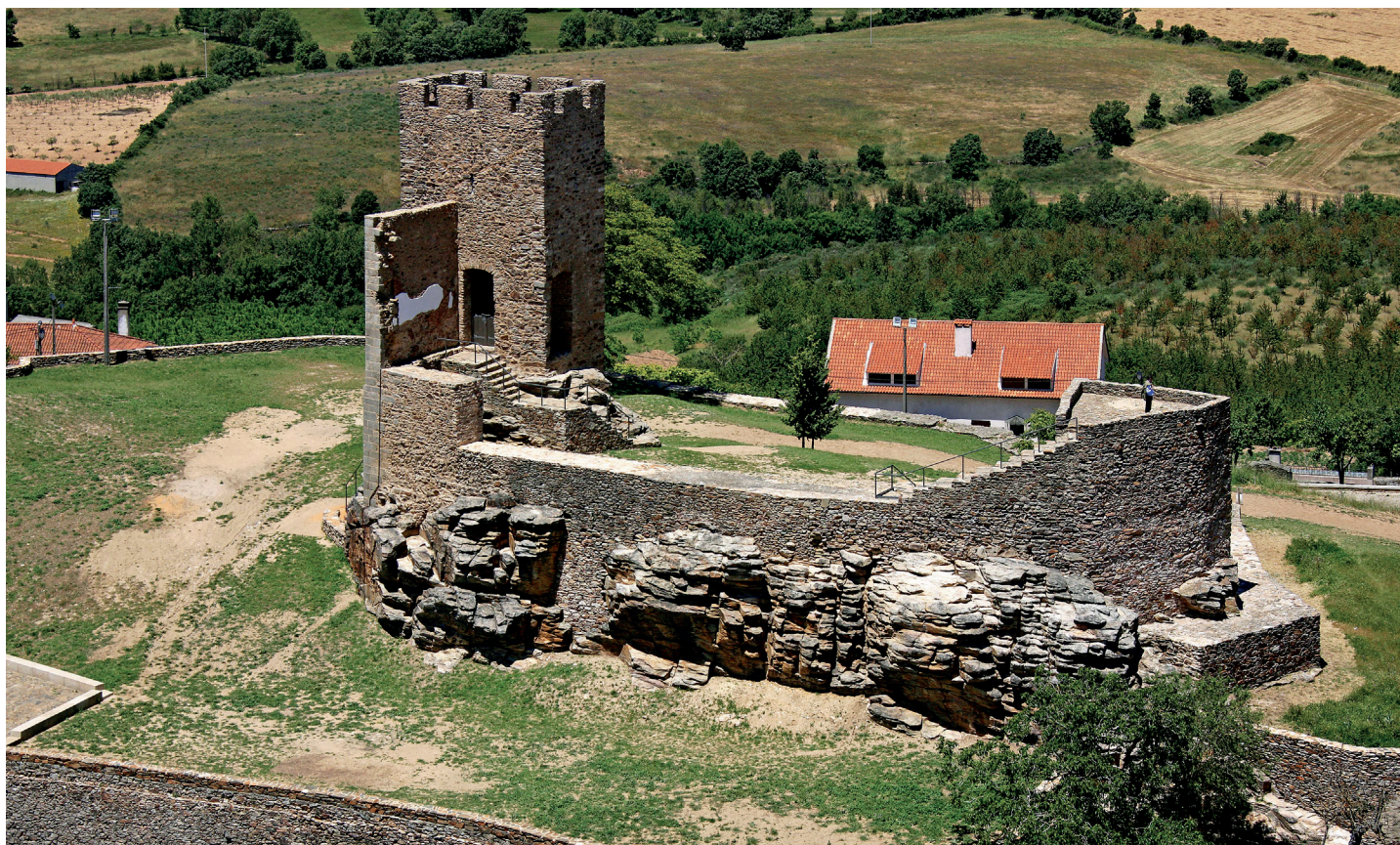
Castelo de Mogadouro, doado pelo rei D. Afonso Henriques aos Templários em 1145 (2008, Direção Regional de Cultura do Norte©, fotografia de Francisco Piqueiro - Foto Engenho - Projectos e Serviços de Fotografia, Lda.)
