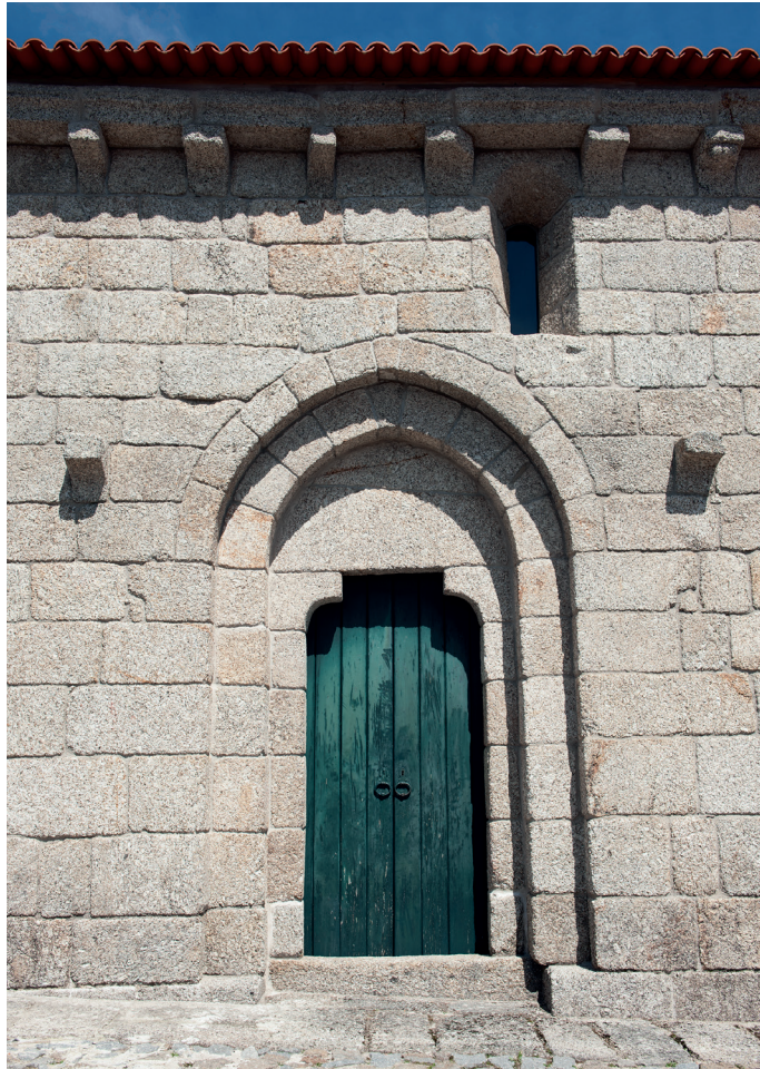
Exterior. Portal sul
