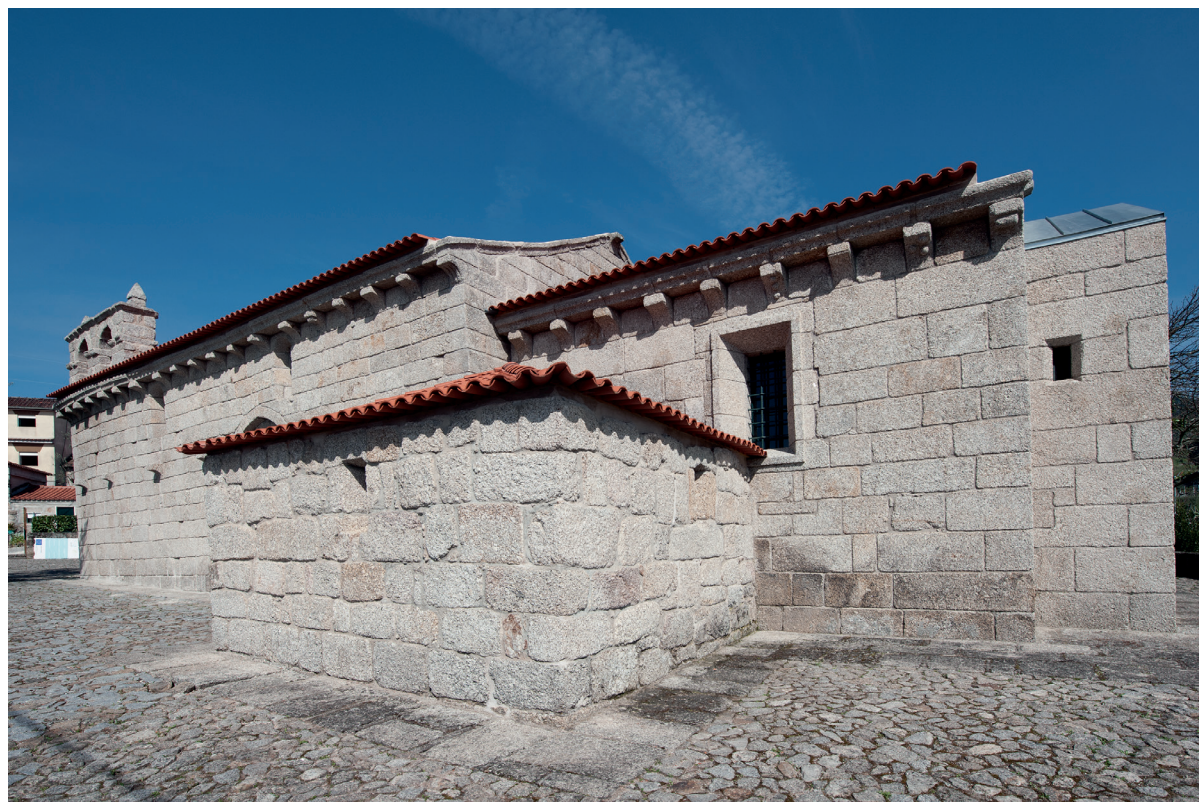
Perspetiva geral da igreja. Alçado sul
