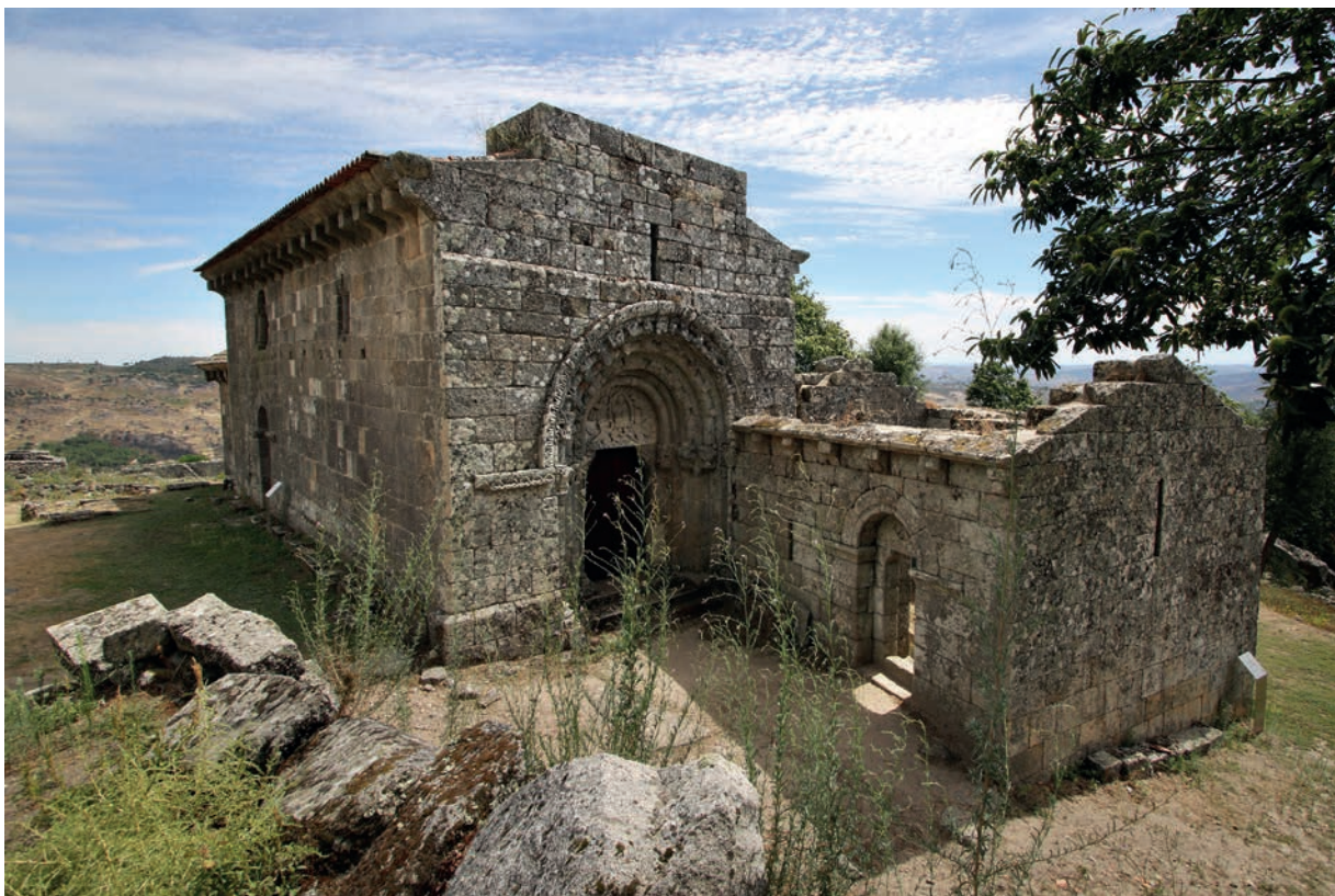
Vista geral a partir de oeste
