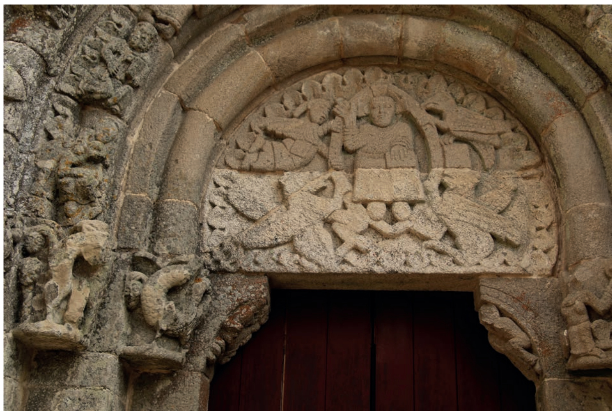
Tímpano do portal ocidental
