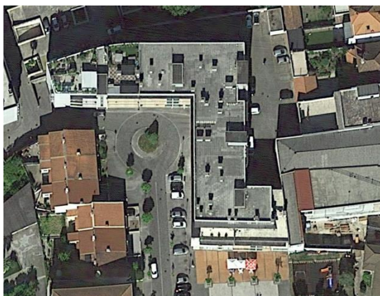
Fig. 7 – Vista aérea do edifício multifamiliar sujeito do caso prático. Fonte: Google
