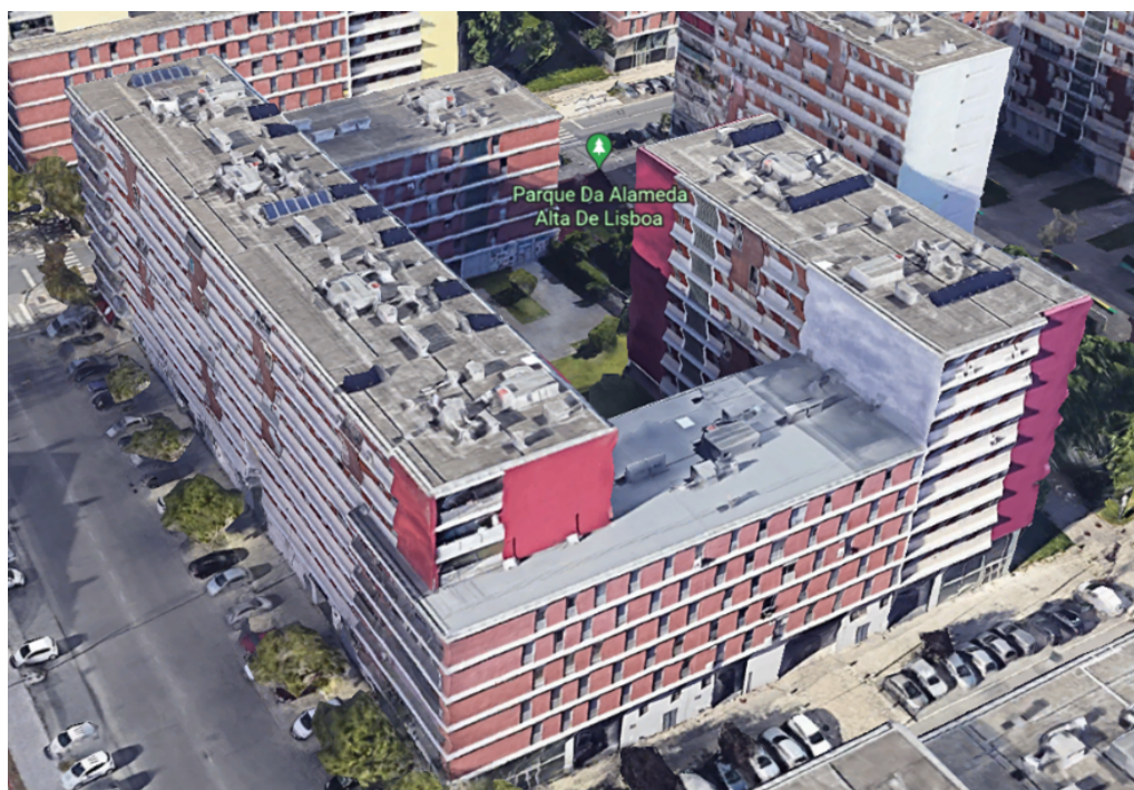
Figura 4.1: Imagem da instalação da CER Alta de Lisboa [90]
