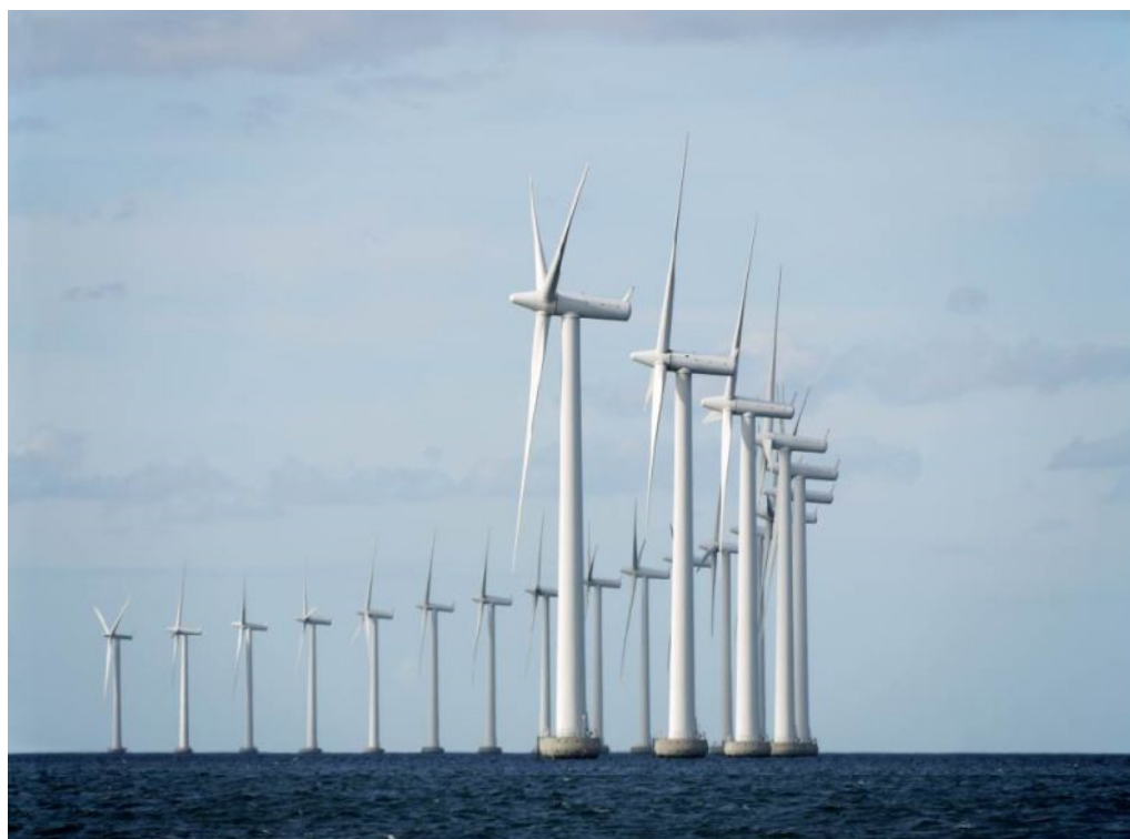
Figura 3.3: Instalação do Parque Eólico de Middelgrunden [77]
