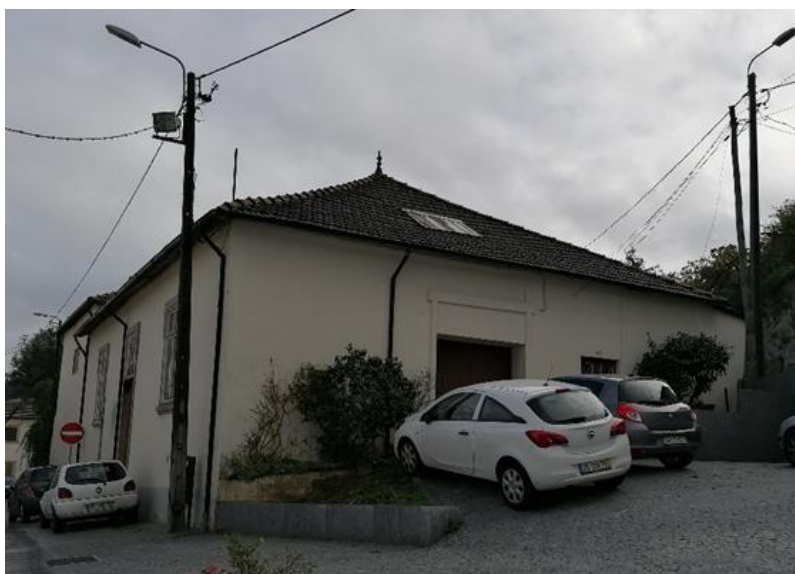
Figura 9 Primeiro Edifício (1933-194-) da Fábrica de Elásticos J.P.C, Ld. a , na Nossa Senhora da Hora, Valongo.
