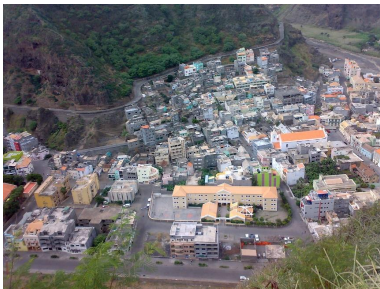
Figura 51 Atualmente a encosta ganhou alguma vegetação devido a sedimentação e infiltração causada pelo muro da estrada.
