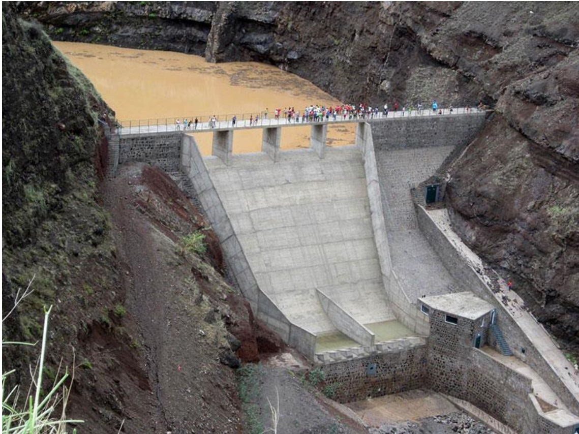
Figura 24 Barragem do Canto de Cagarra. Fonte: Notícias do Norte.
