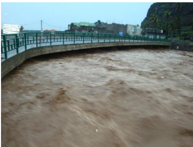
Figura 27 Ponte entre a cidade e o Bairro do Tarrafal ameaçada durante as cheias de 23 de outubro de 2010. Foto: Arlindo Fortes.
