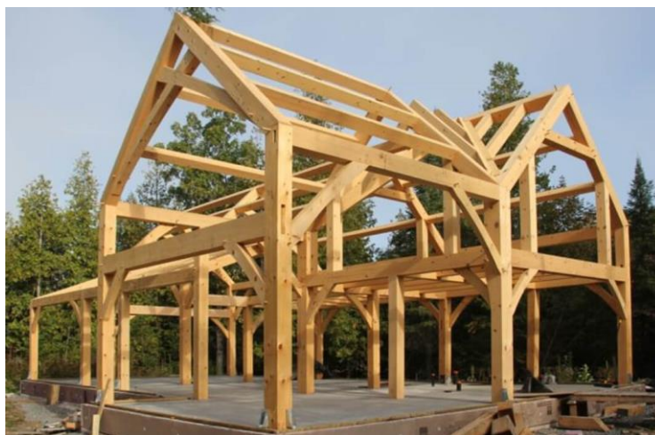
Figura 17 – Timber Frame, fonte [30].
