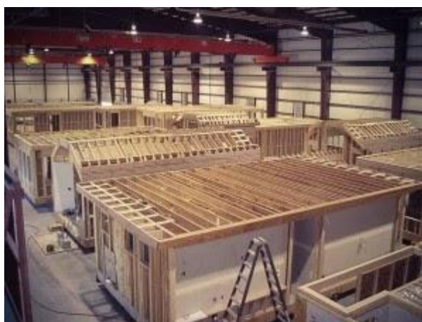
Figura 19 – Construção Modular em Fábrica, fonte [35].
