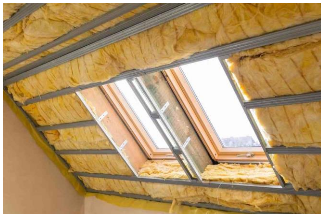
Figura 15 – Isolante Térmico em Parede de Madeira, fonte [29].
