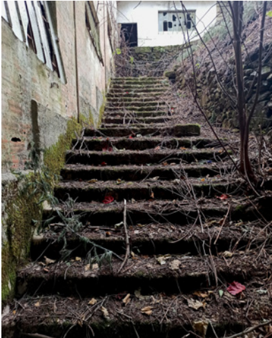
F06- Pormenor de degraus em pedra.
