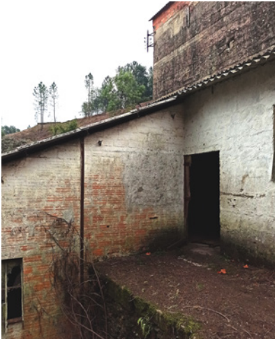
F04- Fotografia de parede de alvenaria de tijolo com marcação de perfis em ferro oxidado.
