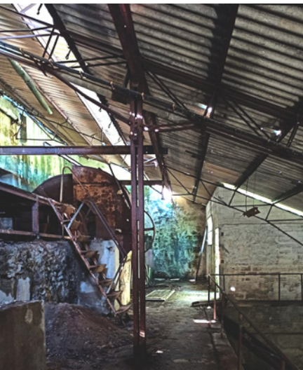
F12- Detalhe de pilar estrutural em ferro com 11,8cm de largura por 14cm de comprimento (em planta).
