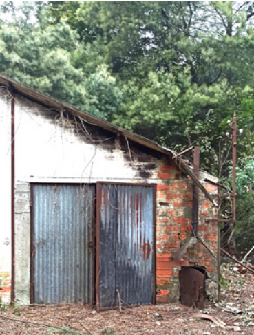
F08- Fotografia de portas de entrada em chapa ondulada, parede de alvenaria de tijolo e chaminé em ferro.
