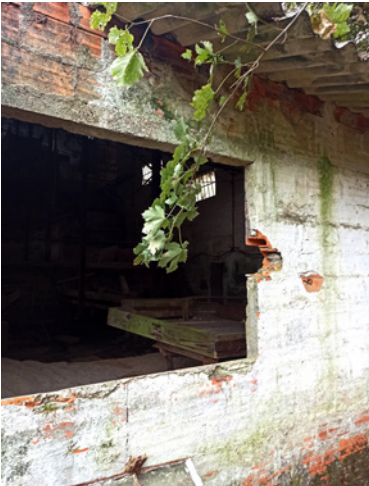
F07- Pormenor de parede de alvenaria de tijolo e cobertura em chapa ondulada de fibrocimento.
