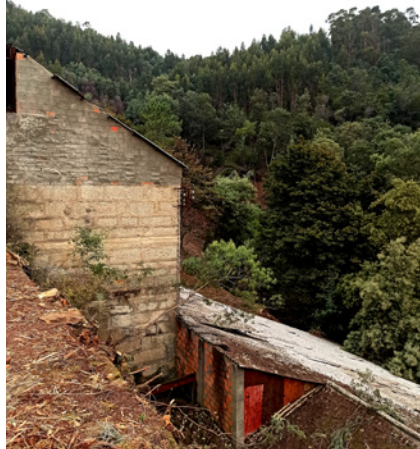
F01- Fotografia de parede mista de alvenaria de pedra e tijolo.
