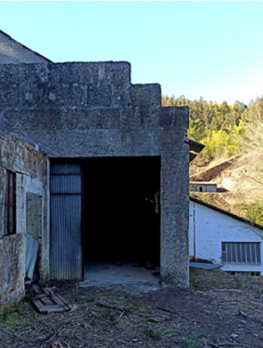
F09- Fotografia de parede de alvenaria de pedra com porta em chapa ondulada.
