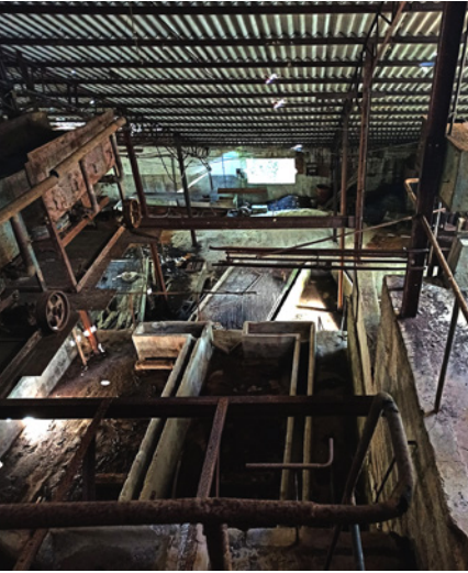
F13- Fotografia de estruturas metálicas com maquinaria associada.
