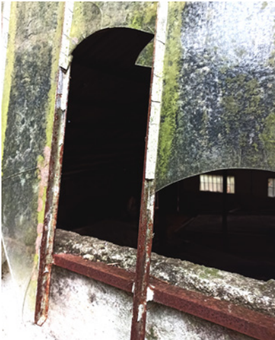
F05- Detalhe de janela com caixilharia exterior em ferro.
