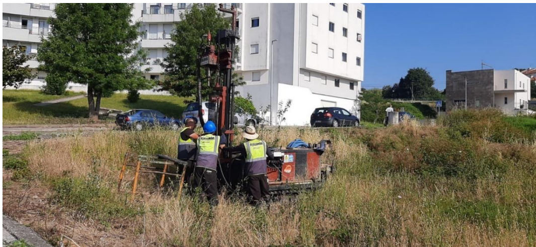
Figura 3 - Realização do ensaio DPSH.
