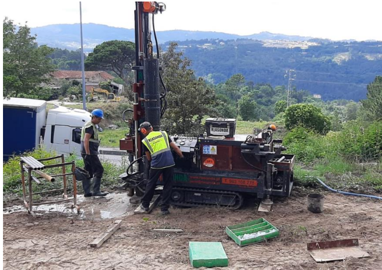
Figura 6 - Realização de sondagem SPT.
