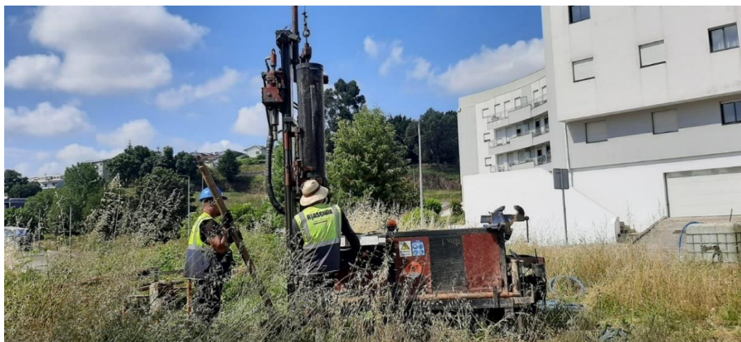
Figura 4 - Realização da sondagem SPT.
