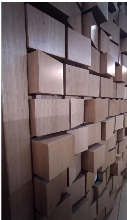
Fig. 4.8. – Pormenor da parede frontal ao palco, à esquerda [foto do autor] e difusor Art Diffusor , à direita [35].
