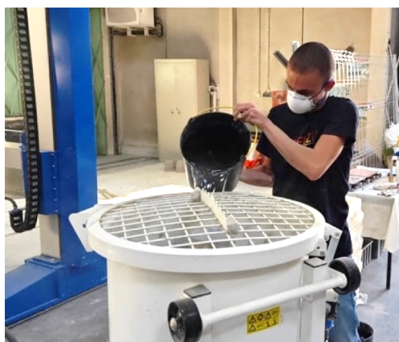
c) Colocar a dosagem de água pesada
