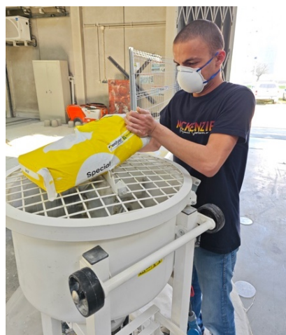
b) Colocar a argamassa na misturadora
