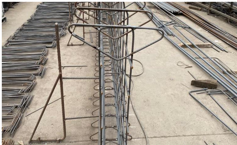
Figura 33 - Marcação no chão para afastamento de estribos
