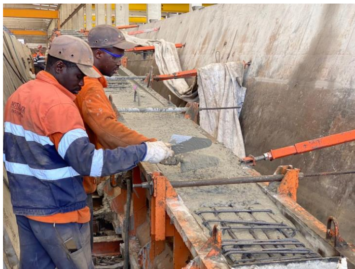
Figura 37 – Betonagem de viga de inércia variável
