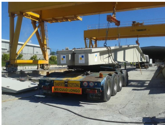
Figura 38 - Içamento de vigas de inércia variável por pontes rolantes
