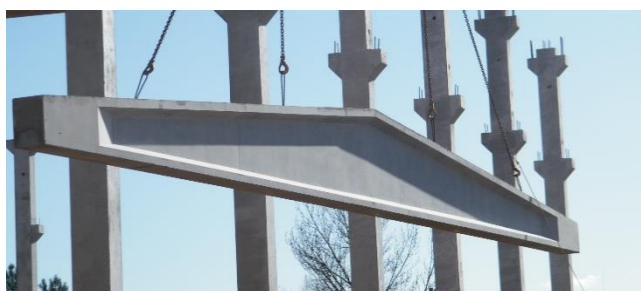
Figura 4 – Viga pré-fabricada pré-esforçada de inércia variável
