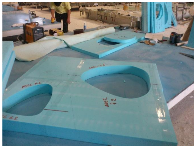
Figura 6 – Molde de painel GRC
