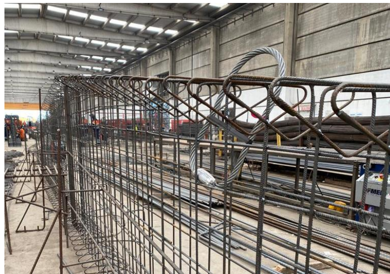
Figura 43 - Argola de içamento da viga
