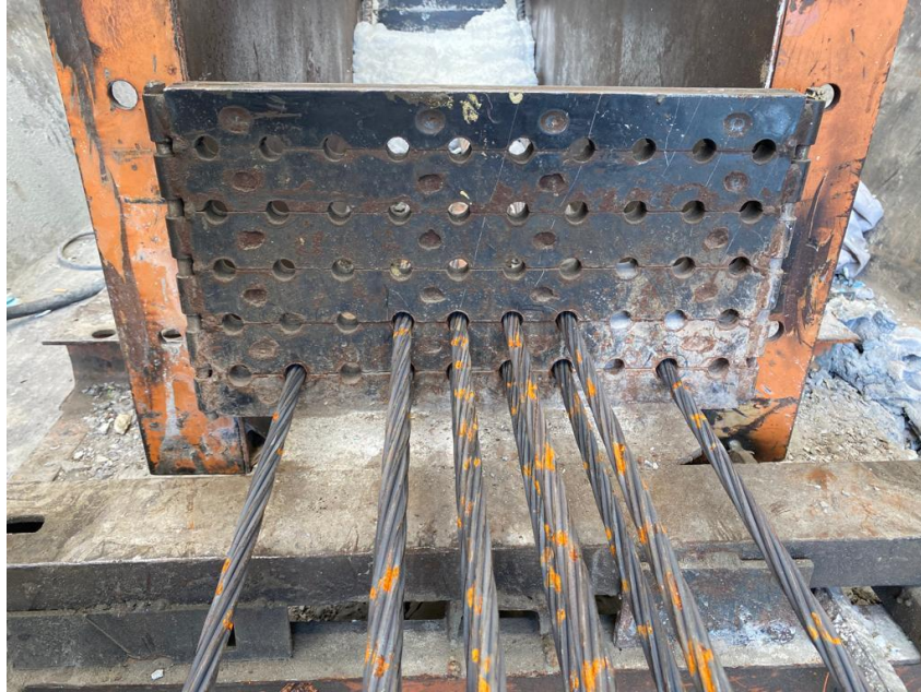
Figura 35 – Gabarito de alinhamento de cordões de pré-esforço
