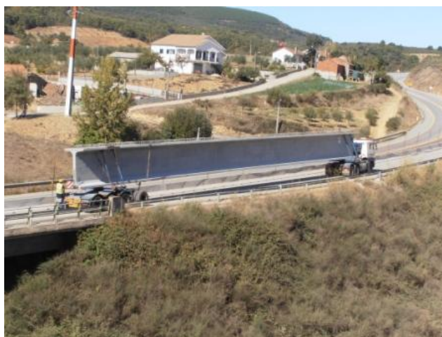
Figura 39 - Transporte de viga em veículo de transportes especiais
