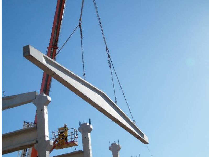
Figura 40 - Montagem de viga de inércia variável com recurso a uma grua automóvel
