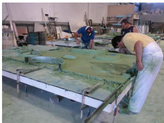
Figura 7 – Fabrico de painel GRC
