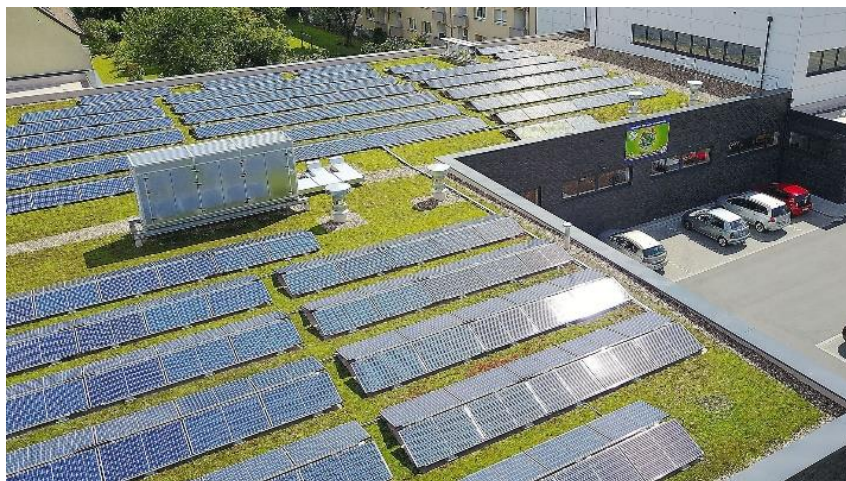
Figura 8 - Cobertura de pavilhão industrial
