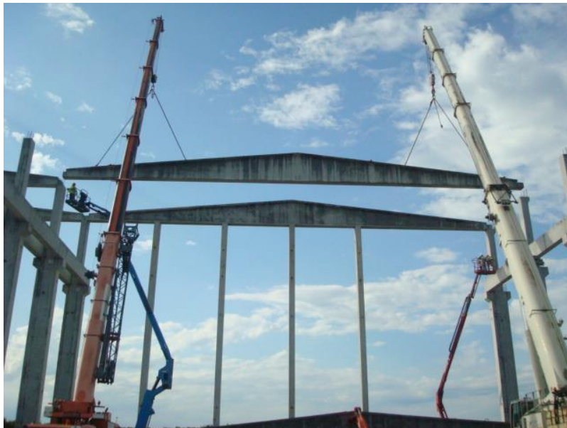
Figura 41 - Montagem de viga de inércia variável com recurso a duas gruas automóveis
