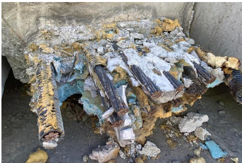
Figura 26 - Topo de viga de inércia variável
