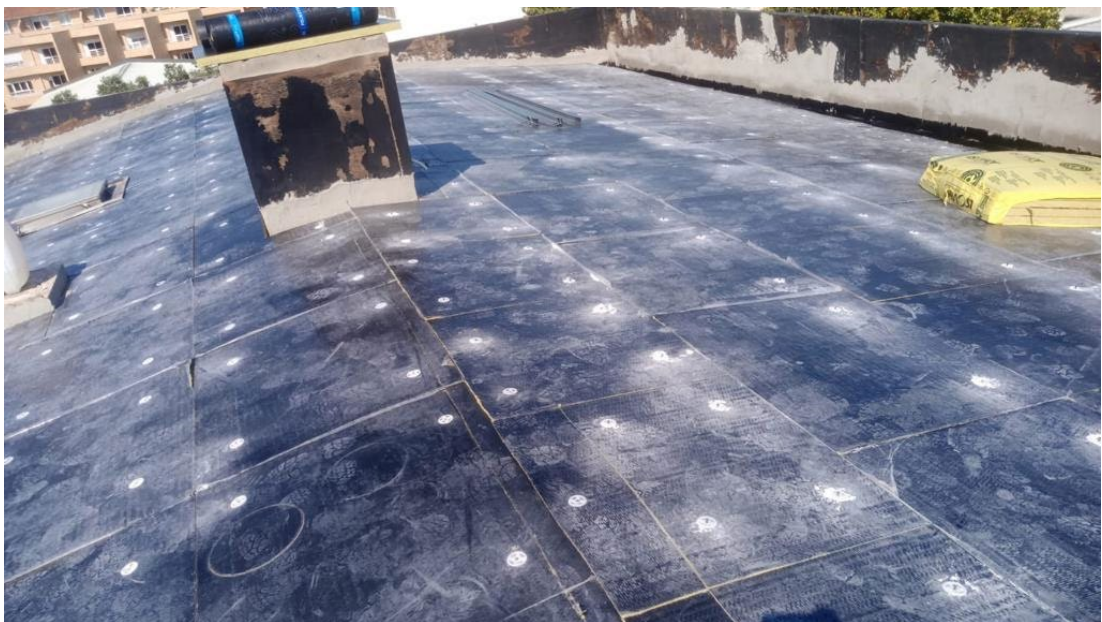
Figura 31: Lã Mineral ISOVER fixada mecanicamente, Reabilitação Universidade de Aveiro 2023
