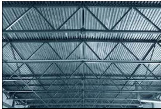
Figura 8:Estrutura resistente flexível – chapas metálicas nervuradas. [13]
