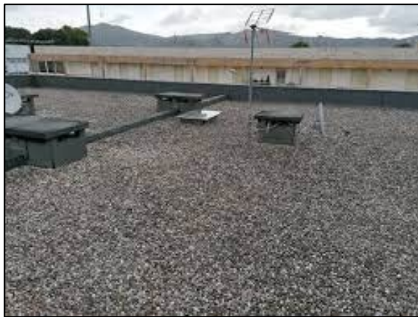
Figura 35: Cobertura não acessível
