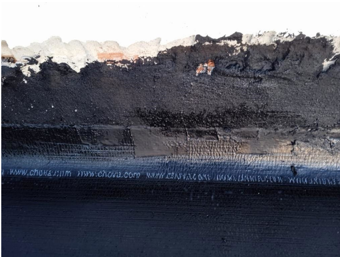
Figura 44: Subida da Membrana de Impermeabilização no encontro de murete, Àgueda 2023
