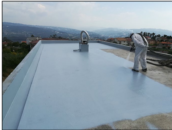
Figura 14: Aplicação de Solução em Poliureia
