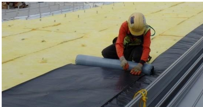
Figura 13: Aplicação e apresentação comercial do material EPDM
