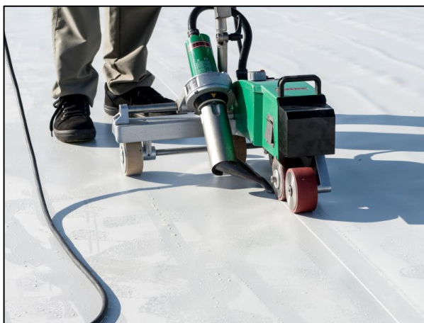
Figura 12: Aplicação de uma membrana Termo-Plástica
