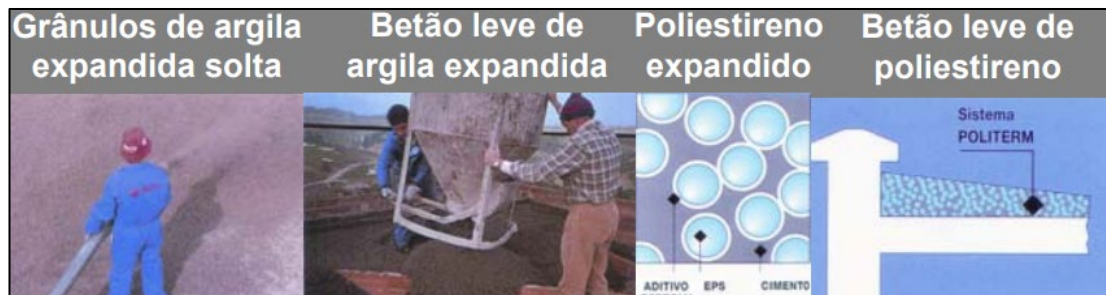
Figura 9: Materiais constituintes da camada de forma [20]
