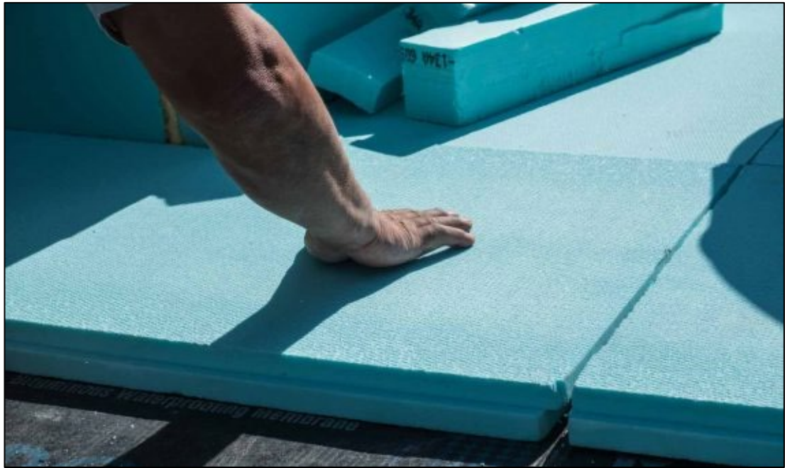
Figura 21: Instalação de placas de Poliestireno Extrudido [7]
