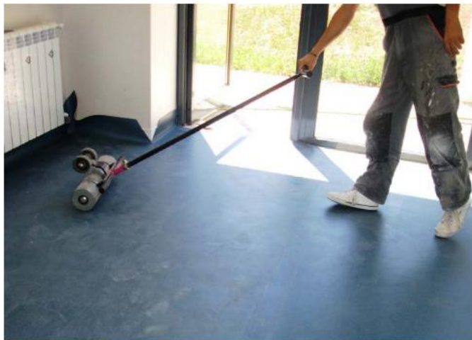
Fig.70 – Aplicação do rolo metálico [37]
