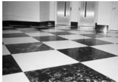
Fig.60 – Revestimento em pedra natural concluído [12]
