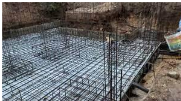
Fig.40 – Ensoleiramento geral
