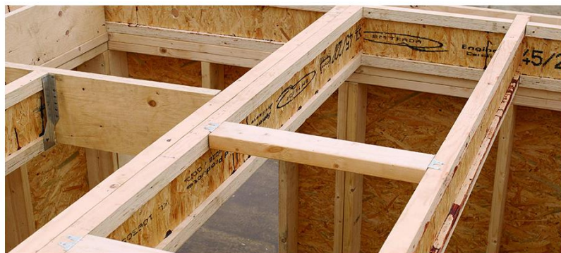
Fig.12 – Estrutura de pavimento com vigas I [20]
