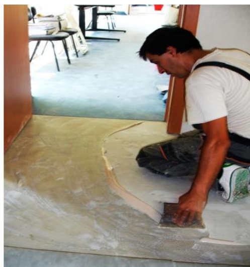
Fig.69 – Aplicação uniforme da cola [37]
