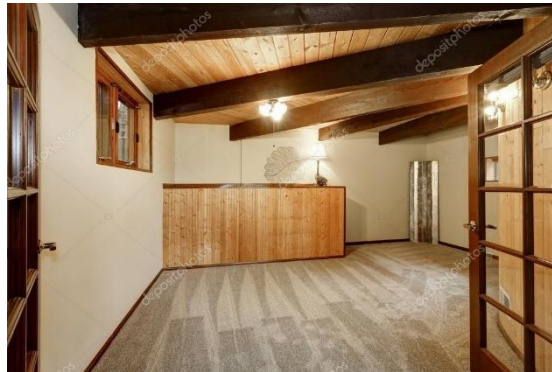
Fig.88 – Teto com vigas de madeira aparentes no teto
