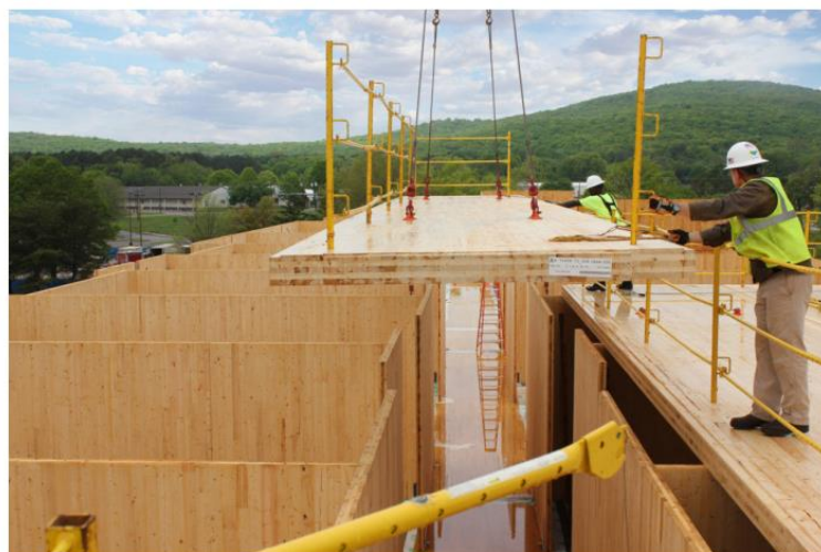
Fig.10 – Painéis de CLT
