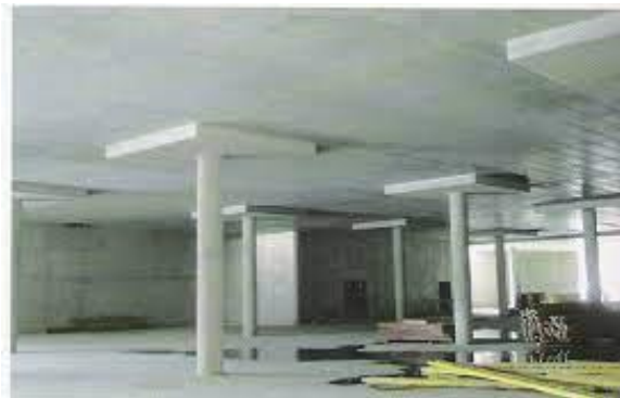
Fig.21 – Laje fungiforme maciça com capitéis [24]
