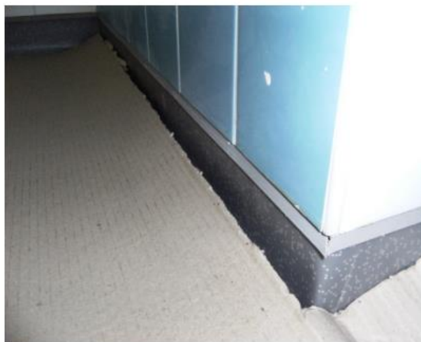
Fig.72 – Proteção do revestimento de piso [37]
