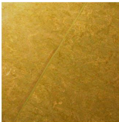
Fig.71 – Soldadura a quente [37]
