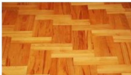
Fig.43 – Revestimento de piso em lamparquet [30]
