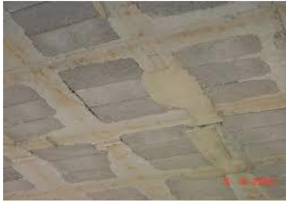
Fig.22 – Laje fungiforme aligeirada [24]
