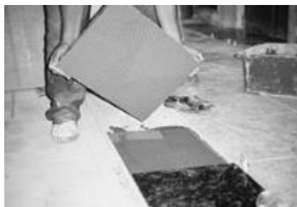
Fig.58 – Aplicação de peças de pedra natural [12]
