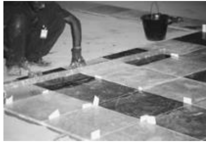
Fig.59 – Batimento das pedras, formando um pano regular [12]
