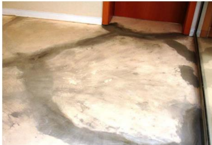
Fig.67 – Suporte completamente limpo e sem gretas [37]
