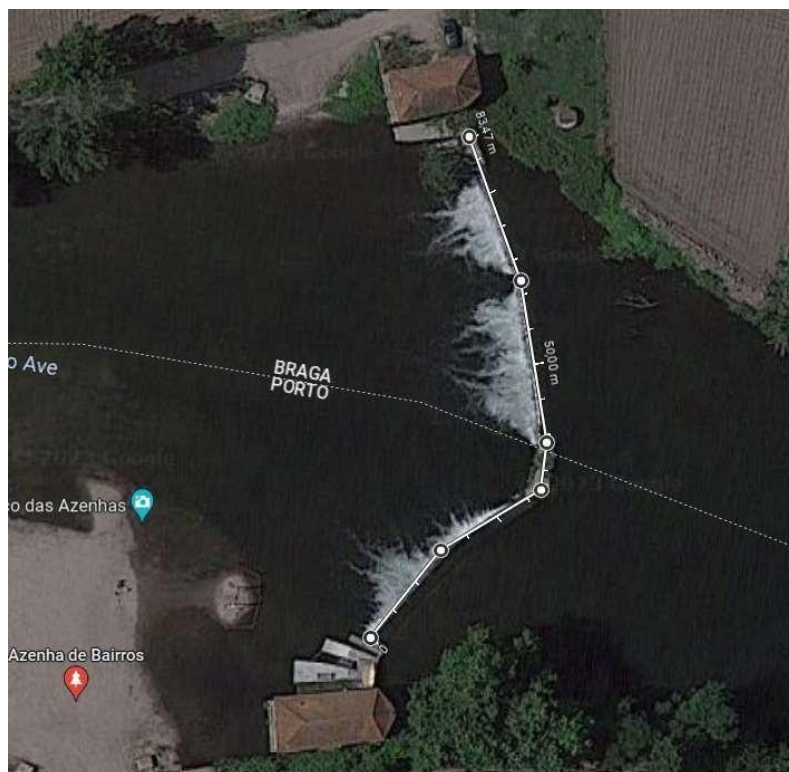
Figura 51- Vista aérea e medição do açude da Azenha de Chaves (margem superior)
