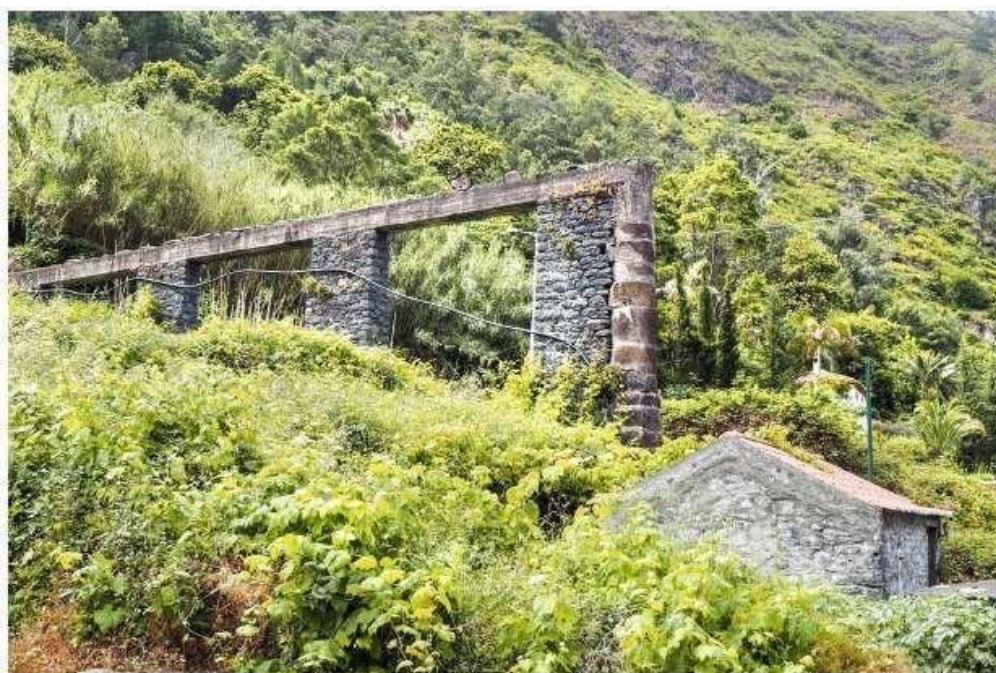
Figura 3- Canal (levada) e torre de pressão de um moinho de rodízio de elevada queda. [5]
