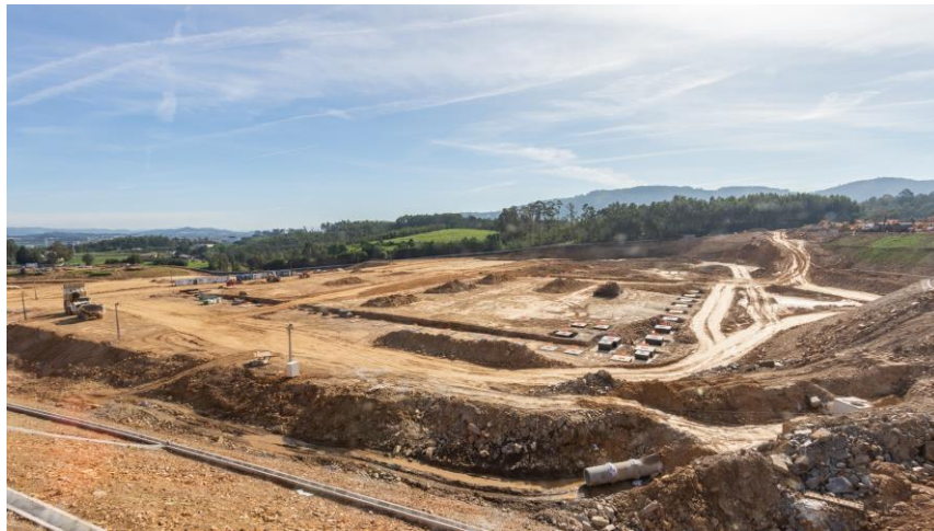
Fotografia obra dia 10/05/2023
