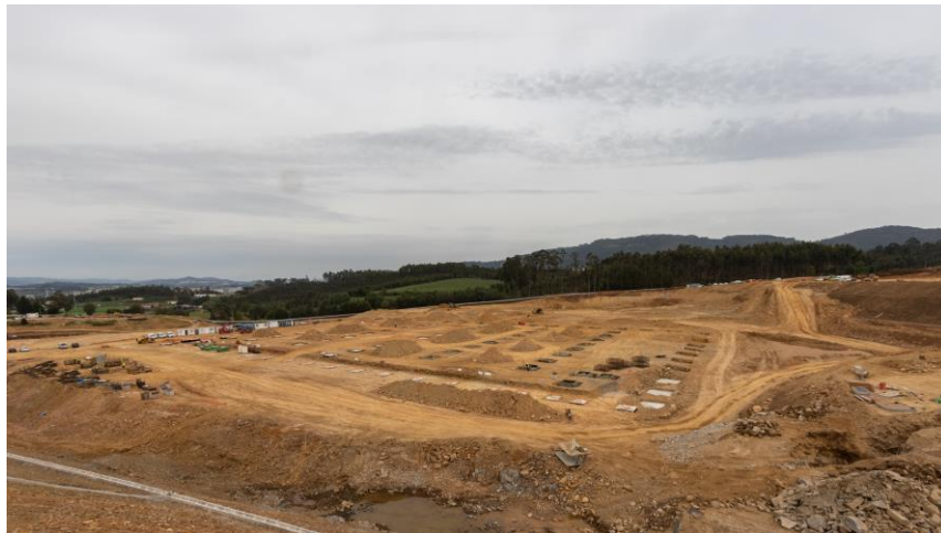
Fotografia Obra dia 12/04/2023
