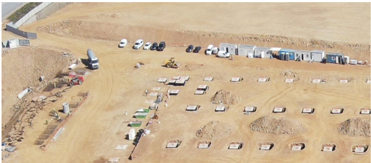
Figura 4.8 – Estaleiro de obra em maio 2023
