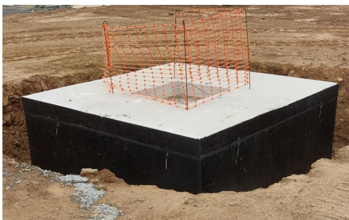
Figura 4.10 - Sapata finalizada
