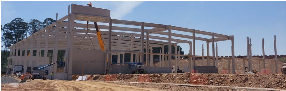
Figura 4.12 - Estrutura pré-fabricada de betão
