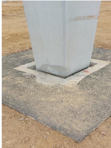
Figura 4.11 - Fixação pilar sapata
