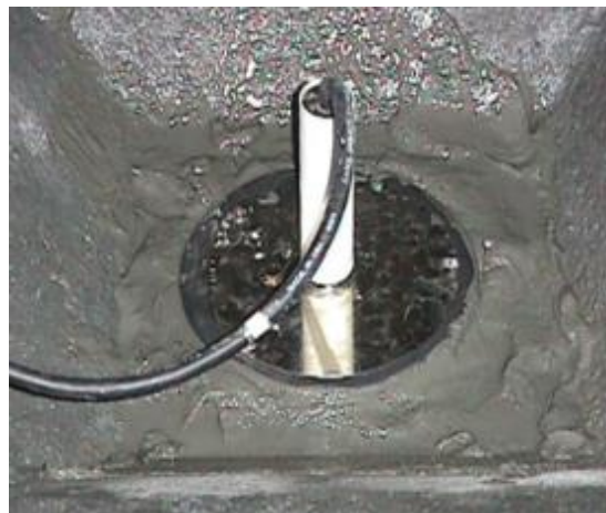
Figura 15 - Tensómetro de resistência antes da betonagem, retirado de (Mata, 2013).
