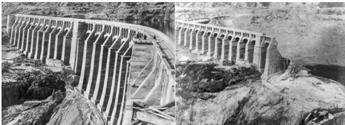
Figura 4 - Barragem de Gleno antes e depois da catástrofe, adaptado de (Luino et al , 2014).
