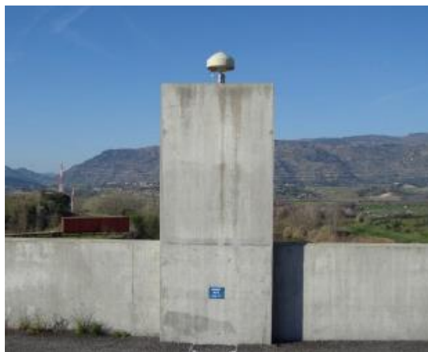
Figura 11 - Antena GNSS localizada no coroamento da barragem, retirado de (LNEC, 2020).
