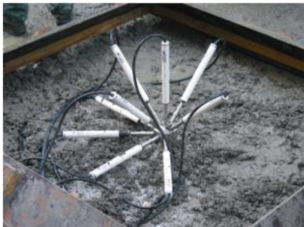
Figura 14 - Grupo de extensómetros de resistência elétrica antes da betonagem, retirado de (Mata, 2013).
