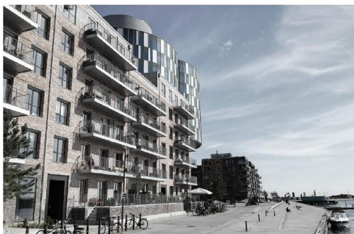
Fig. 15 – Bairro Århusgade à beira-mar
